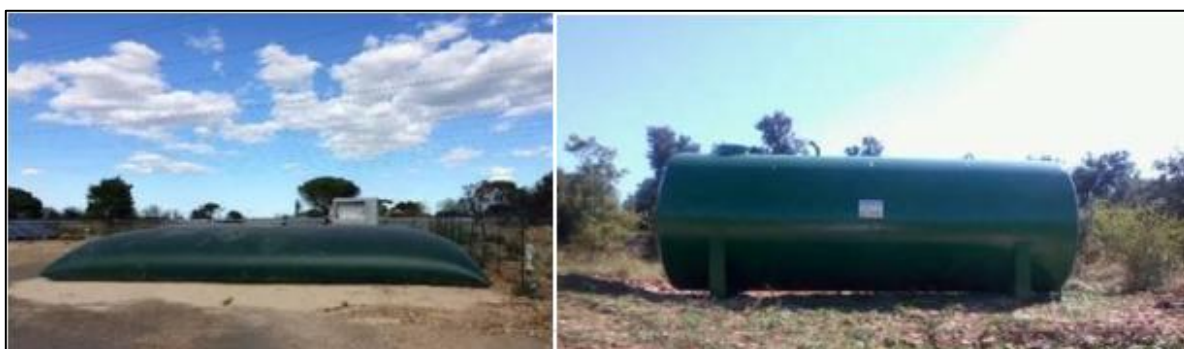
Figure 16 – Exemple d'une citerne souple et d'une citerne en dur (Source : EDF power solutions)
