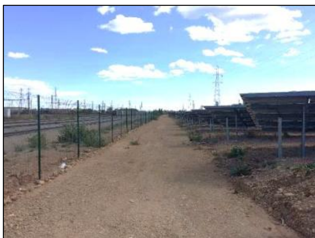
Figure 14 – Exemple de piste périphérique (Source : EDF power solutions)
