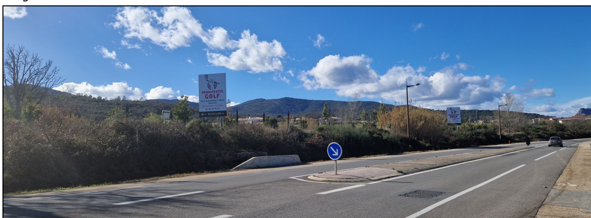
Vue 2 depuis l'est et la RD 7
