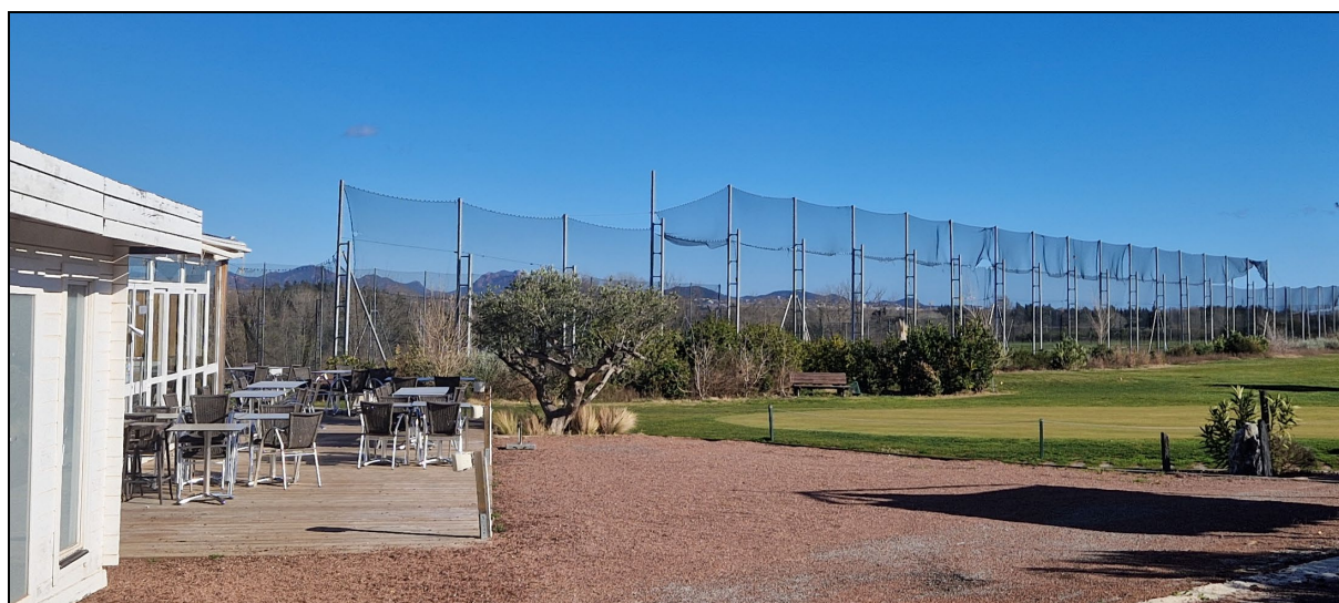
Vue 5 depuis le sud et le domaine existant
