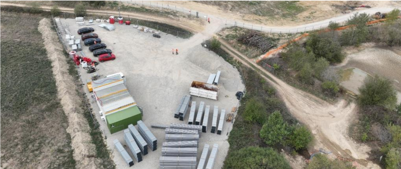
Exemple de base vie avec bungalows et utilités, zones de stockage et de stationnement
