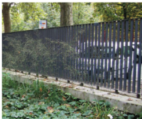
Muret et clôture barreaudage fer plat avec plantations
