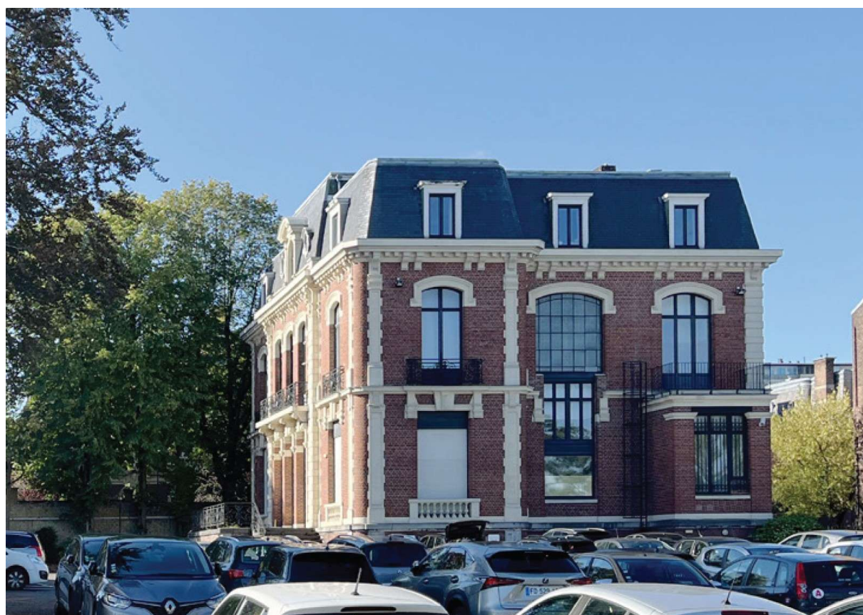
Figure 3. La maison de maître
