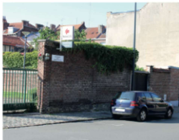
Mur rue Barbieux (nord)
