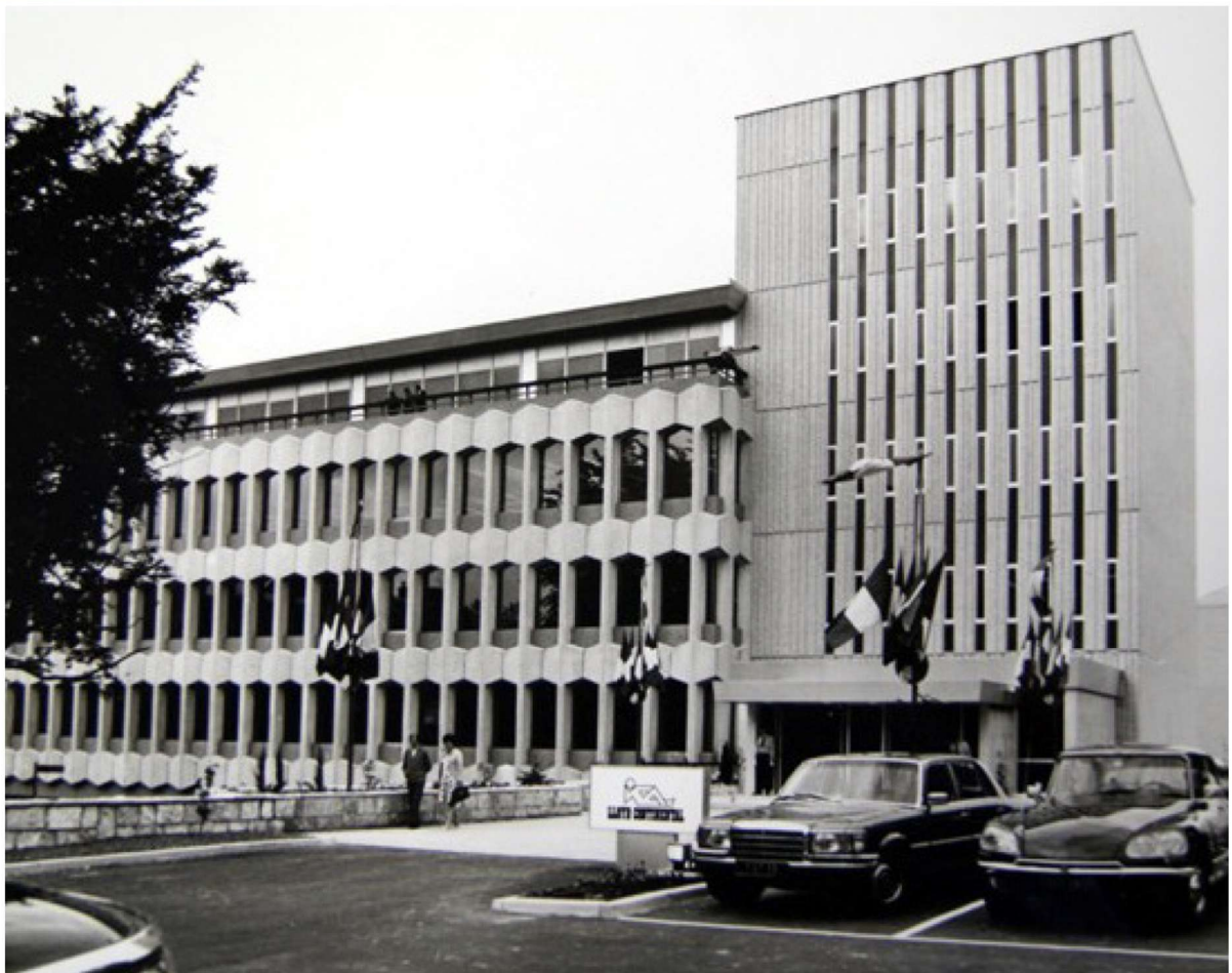
Figure 5. Le bâtiment dit "75", inauguré en 1971 et destiné à accueillir le nouveau parking sécurisé
