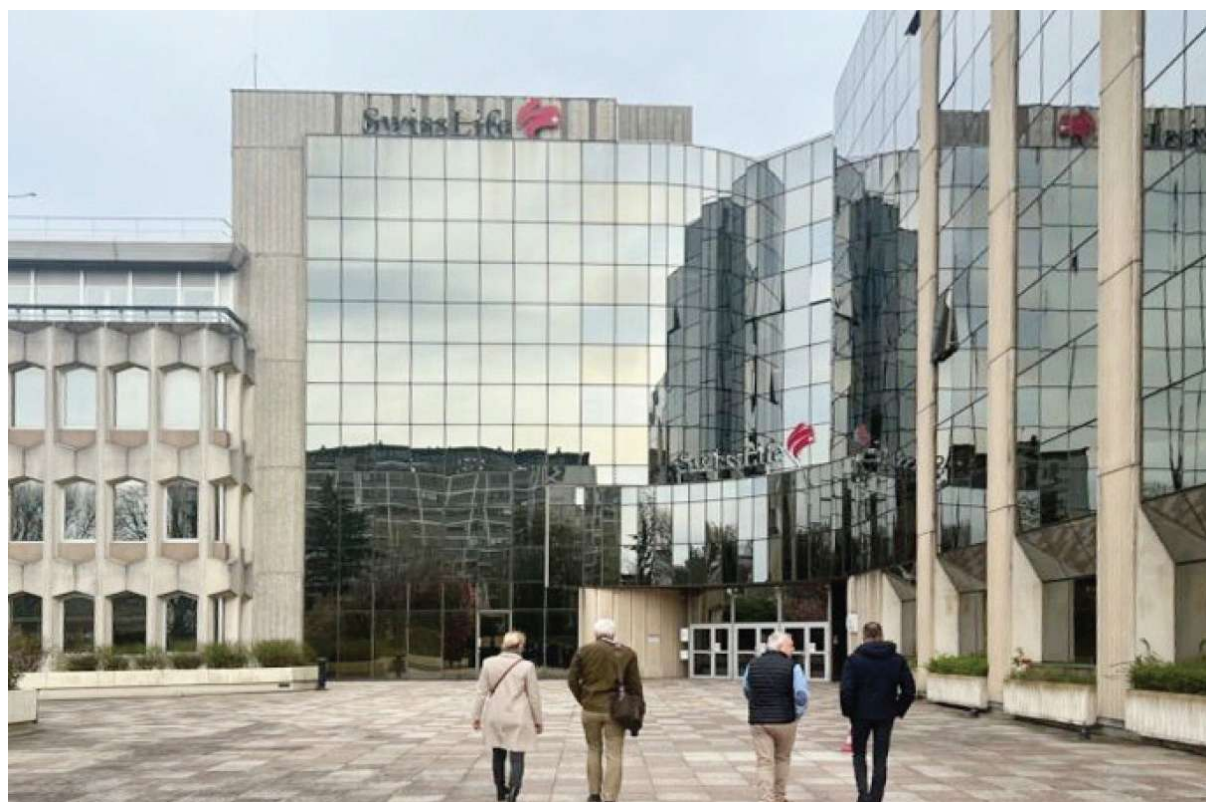
Figure 6. Le bâtiment dit « 88 », destiné à être démoli
