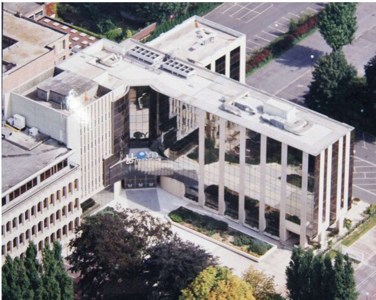
Figure 7. Le bâtiment dit "88".
