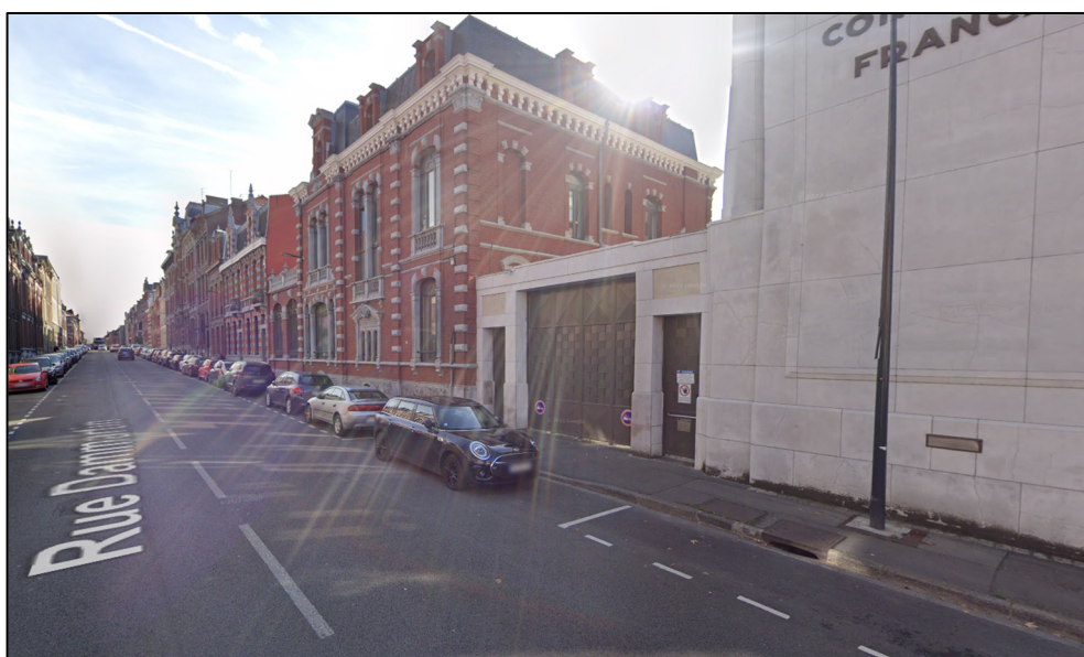
PHOTO 7 – Rue Dammartin – Bâtisses historiques
