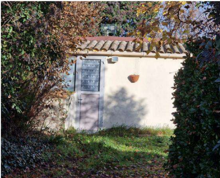
Photo 9 : Bâti existant sud-ouest
