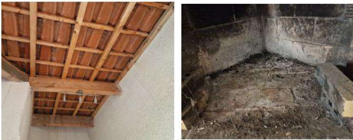
Figure 38 : Bati existant nord
