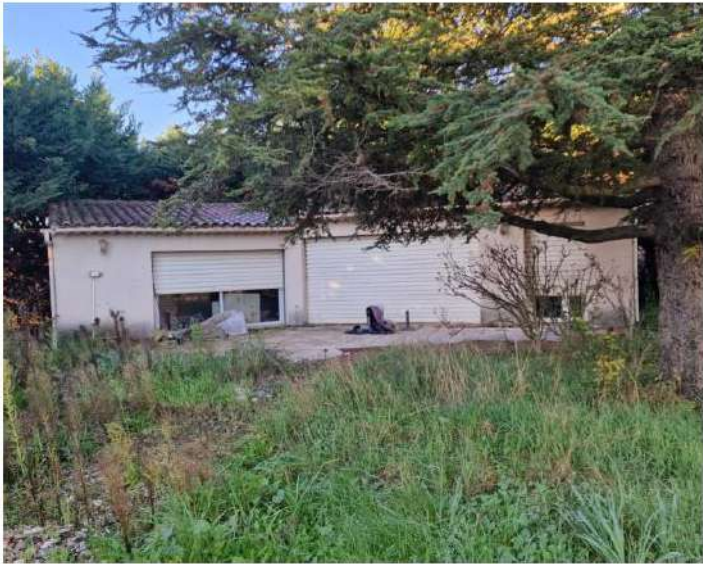
Photo 8 : Annexe nord Le 03/12/2024, des crottes de Tarente de Maurétanie ont été observée sur la terrasse
