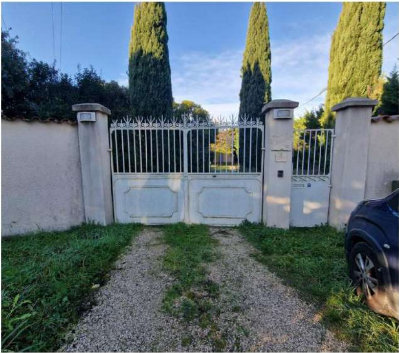
Photo 1 : Accès au chantier existant Nord
