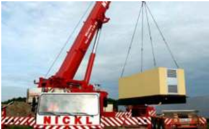
Figure 100 : Exemple d'acheminement d'un poste technique préfabriqué
