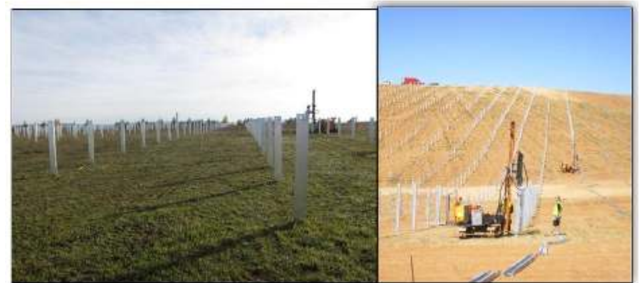
Figure 99 : Exemple de pieux battus dans le sol avec une batteuse visible en arrière-plan
