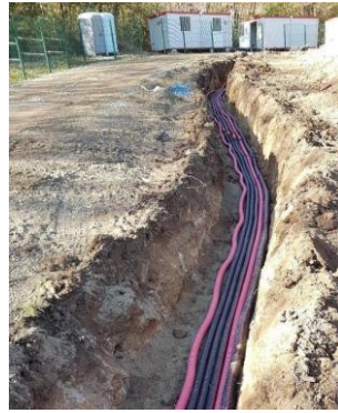
Figure 3 : Photographie des tranchées réalisés pour une centrale de Corsica Sole
