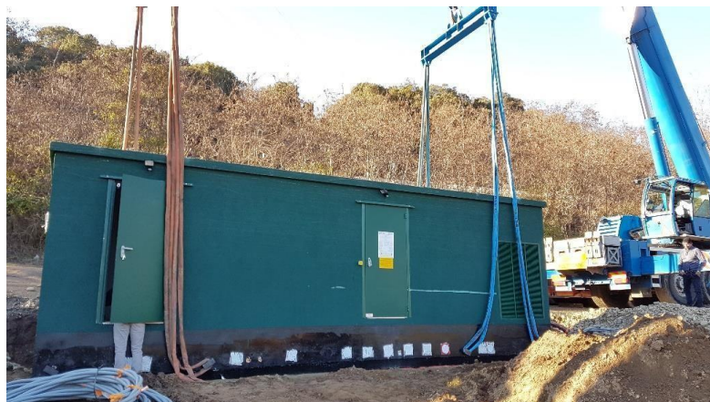
Figure 4 : Photographie de l'installation d'un local technique
