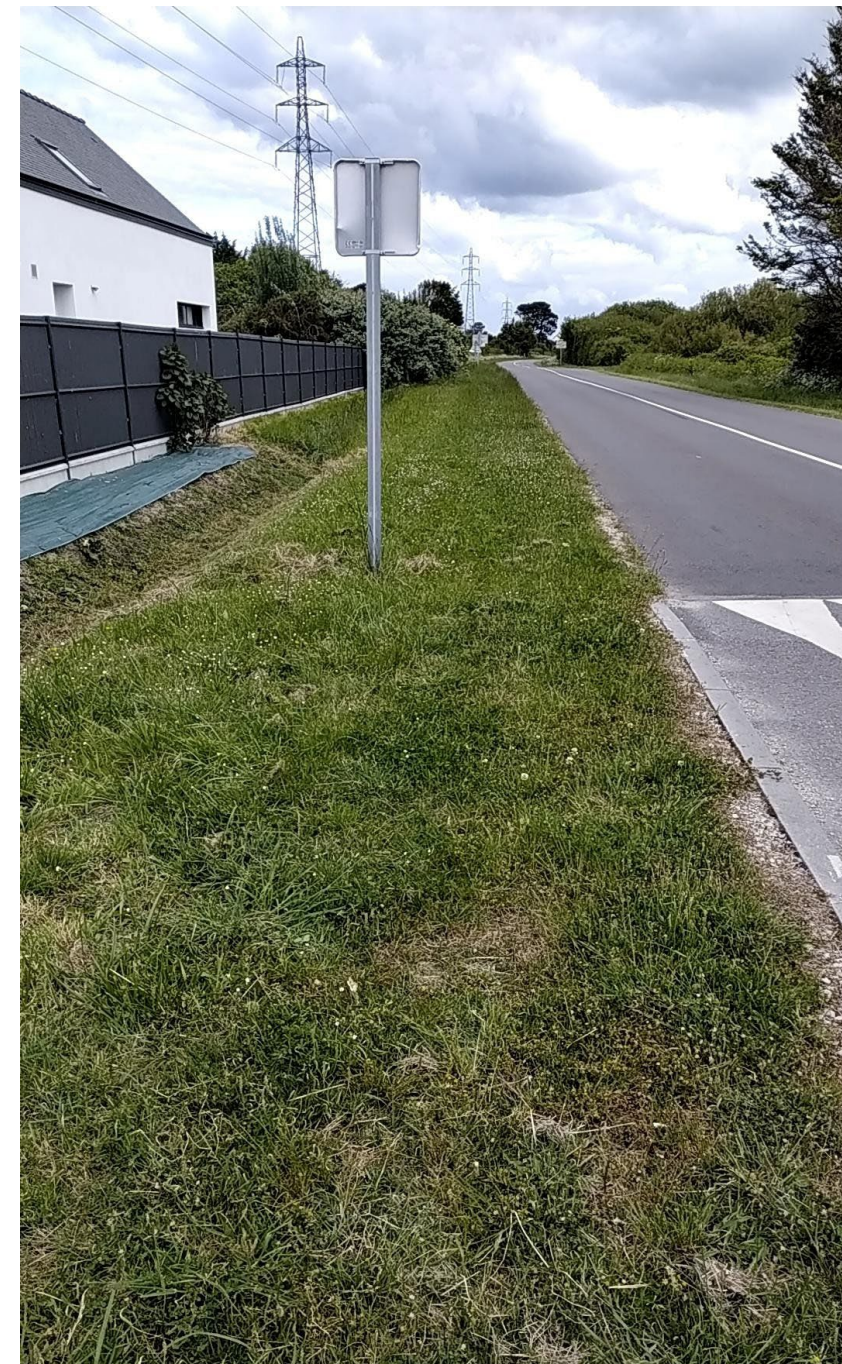
Figure 21 : Bande enherbée des accotements de la voirie
