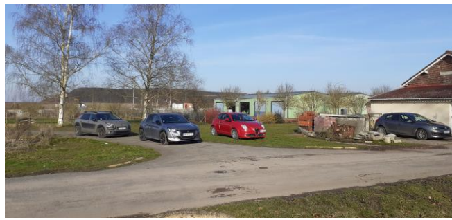
2-Partie Nord du site avec les bâtiments en arrière-plan destinés à être démolis
