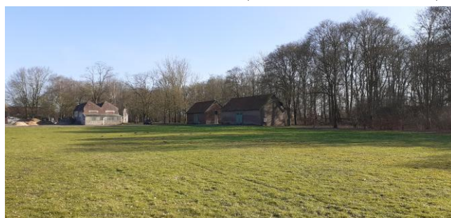
6 – Vue sur les bâtiments à démolir
