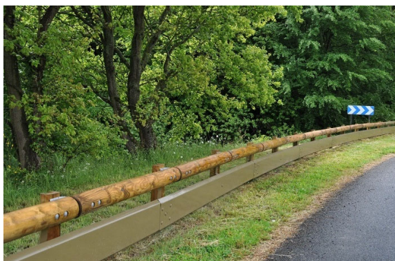
Figure 3-5 : Illustration glissière mixte bois/acier + SPM
