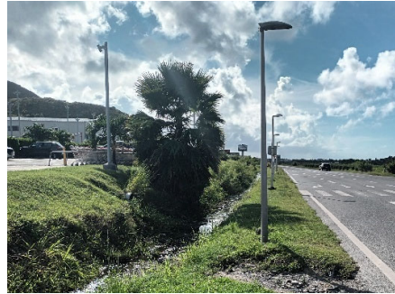
Figure 3-7 : Mât d'éclairage existant
