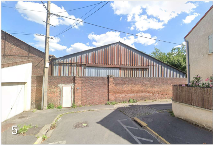
Vue sur les bâtiments présents dans la partie nord du site au débouché de l'avenue Pasteur
