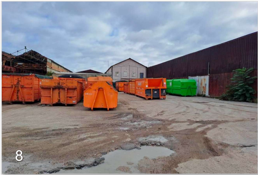
Vue sur les bâtiments présents et les espaces occupés de la partie sud du site
