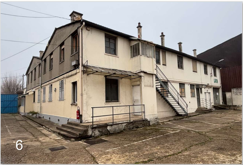
Vue sur les bâtiments présents dans la partie nord du site à proximité de l'entrée du site sur l'avenue Carnot
