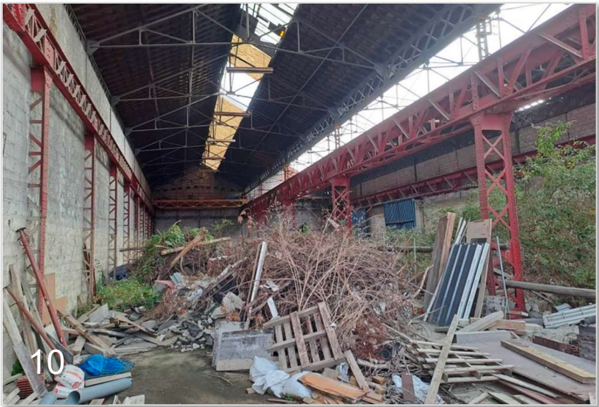
Vue sur l'intérieur d'un des bâtiments présents dans la partie nord du site
