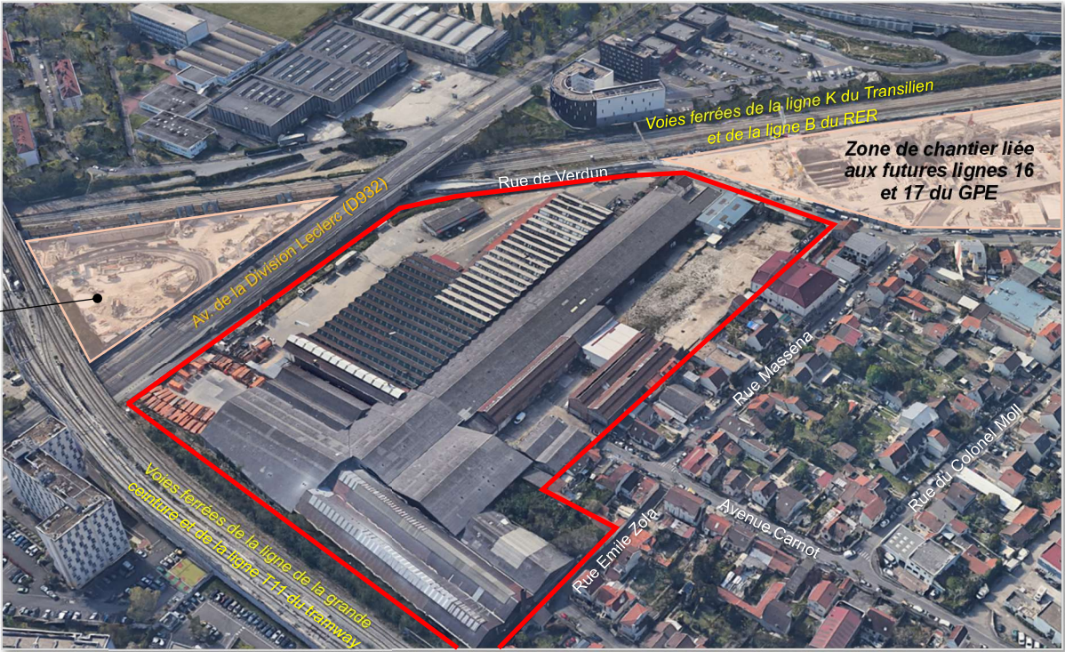
Vue en direction de l'ouest
