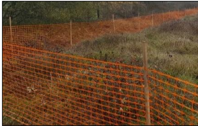
Figure 7 – Exemples de filet de balisage en phase travaux
