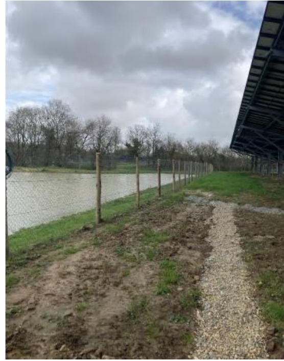
Image 2: Tranchées drainantes et un bassin de rétention sur un chantier réalisé par Technique Solaire en Loire-Atlantique.
