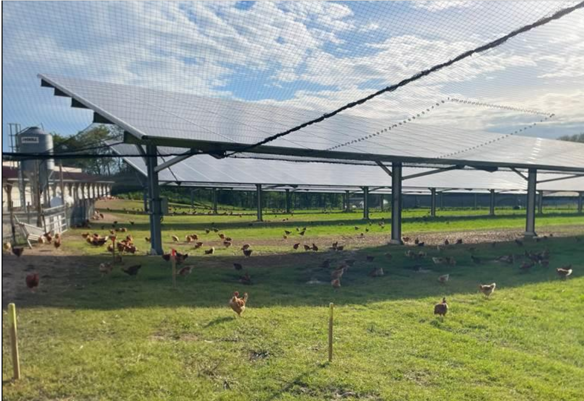
Figure 12 : Photographie d'une volière photovoltaïque Technique Solaire (47) dans le cas d'un élevage de poulets de chair, avec à gauche le bâtiment d'élevage relié directement aux panneaux solaires et à la clôture périphérique, formant un clos total.
