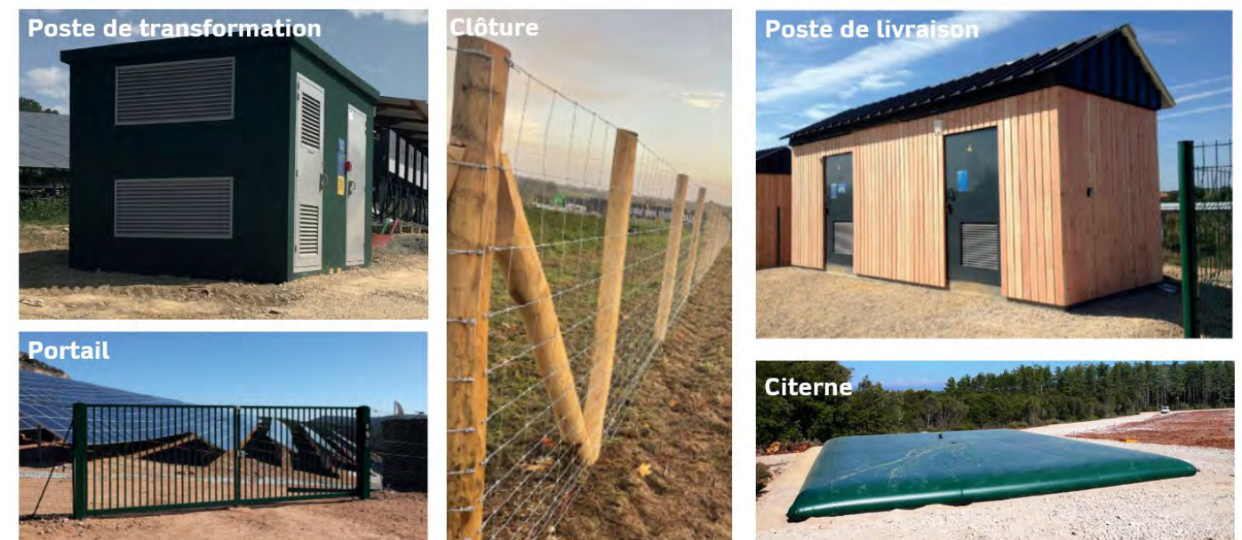
Eléments techniques d'une centrale
