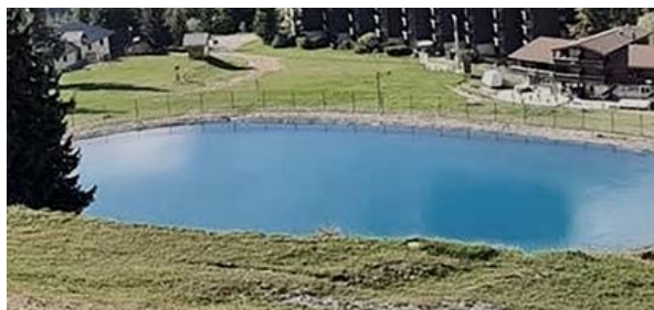
Retenue de Cabane (5 000 m 3 )
