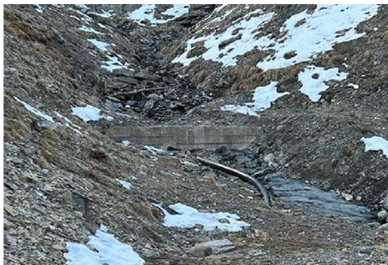
Captage de Vallenchasses (alt. 1 660 m)
