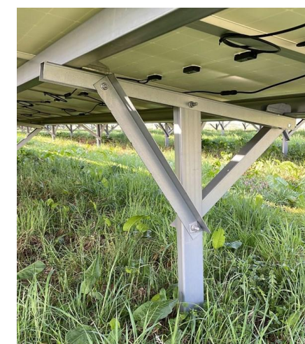
Figure 24 : Pieu battu (source : Siguesol)
