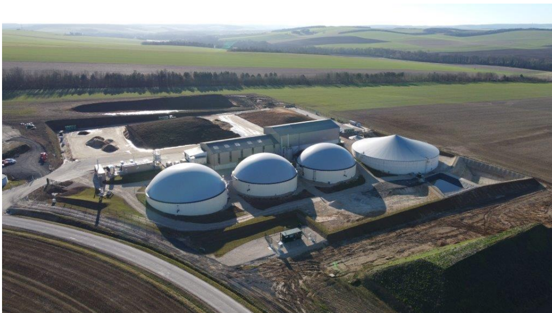
Figure 10 : Vue aérienne des digesteurs, du post-digester et de la cuve de stockage (Source : ENEBIO)
