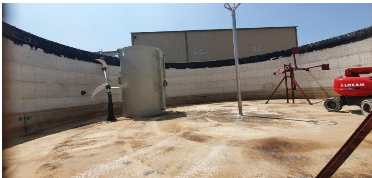
Figure 11 : Brasseur paddle (à gauche) et agitateur axial (à droite) (Source : ENEBIO)
