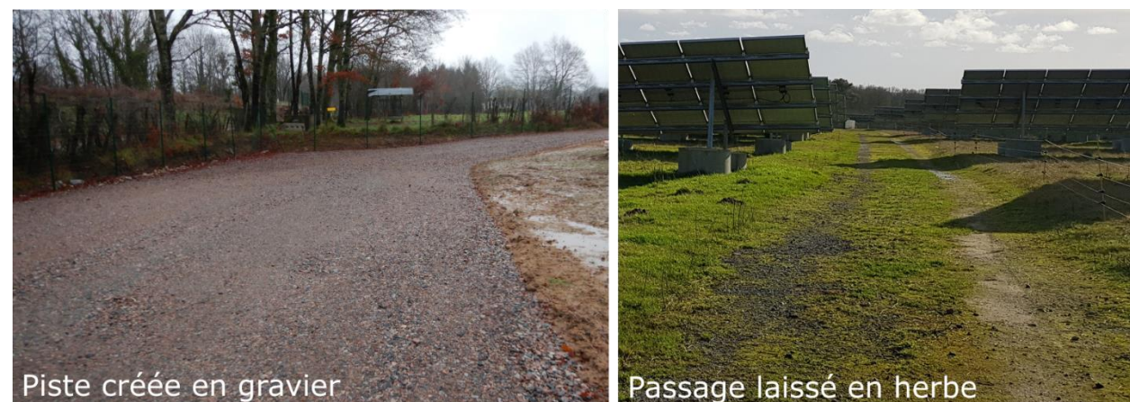
Photographie 8 : Exemple de pistes empierrées et enherbées (Source : ENCIS Environnement)
