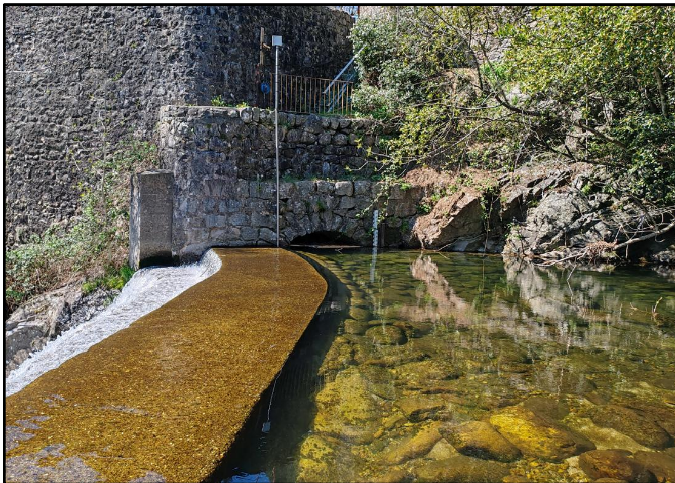
Figure 7 : Prise d'eau située en rive droite – vue amont
