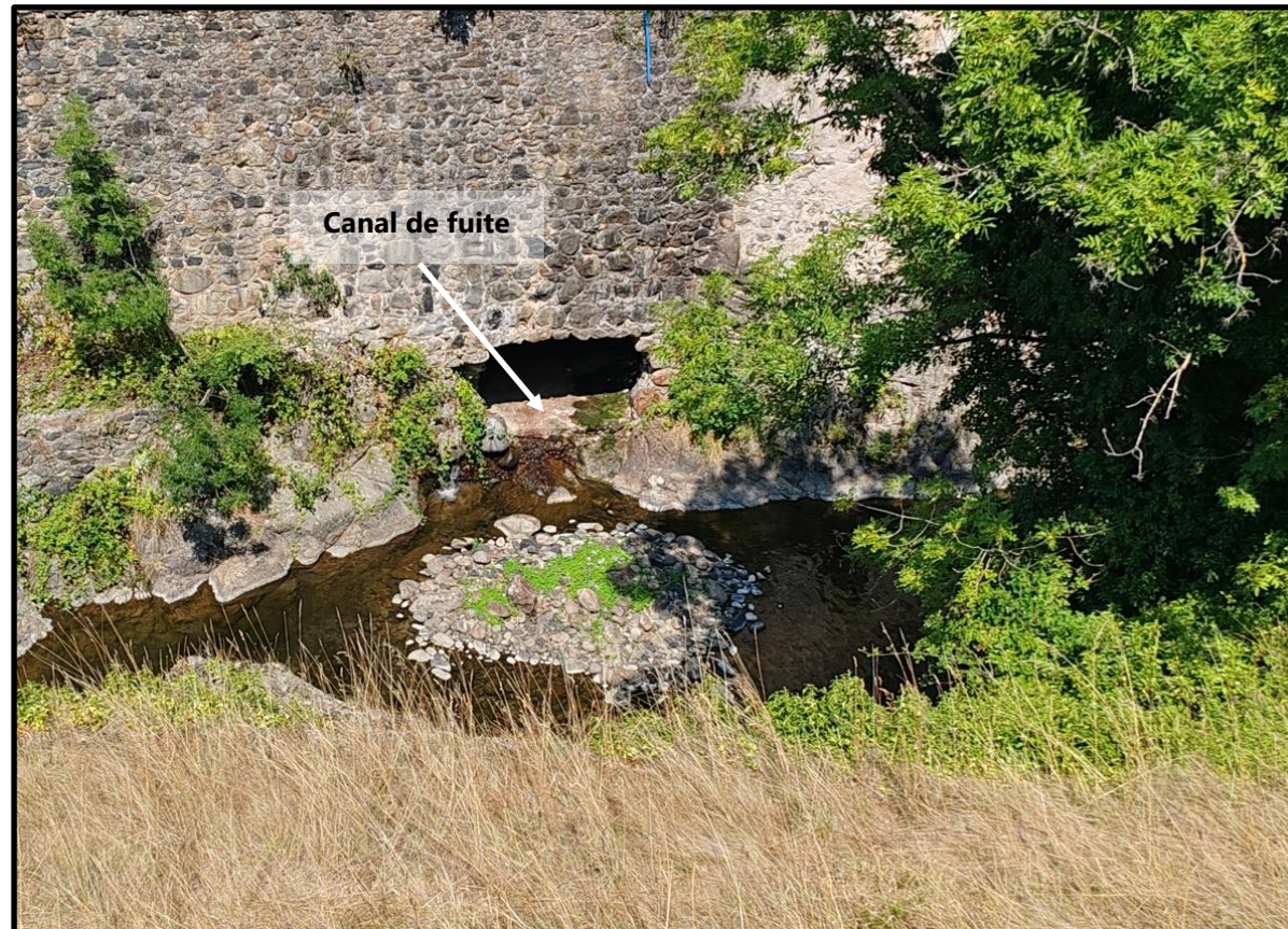
Figure 9 : Canal de fuite
