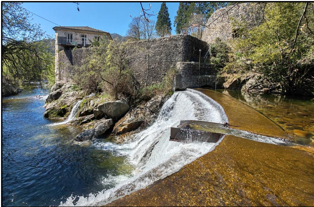
Figure 6 : Barrage de la MCHÉ – vue depuis la rive gauche
