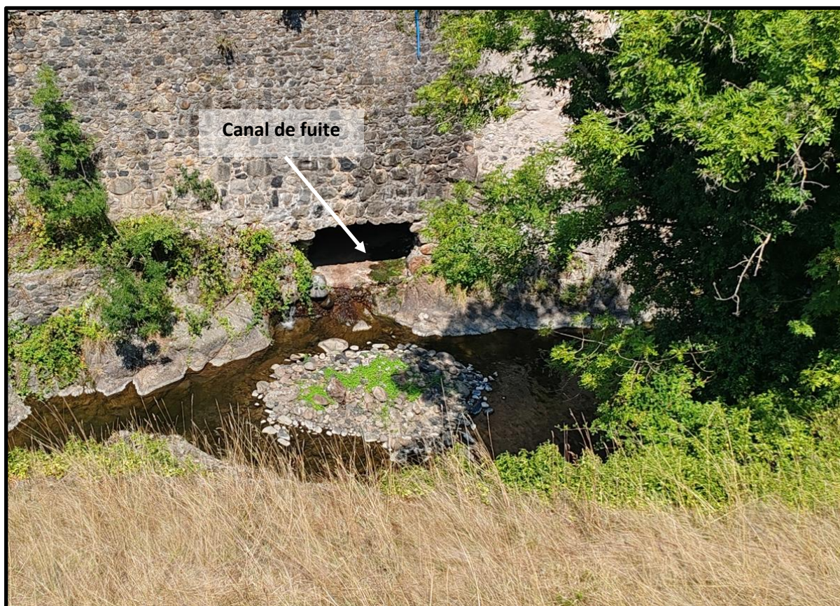
Figure 10 : Canal de fuite
