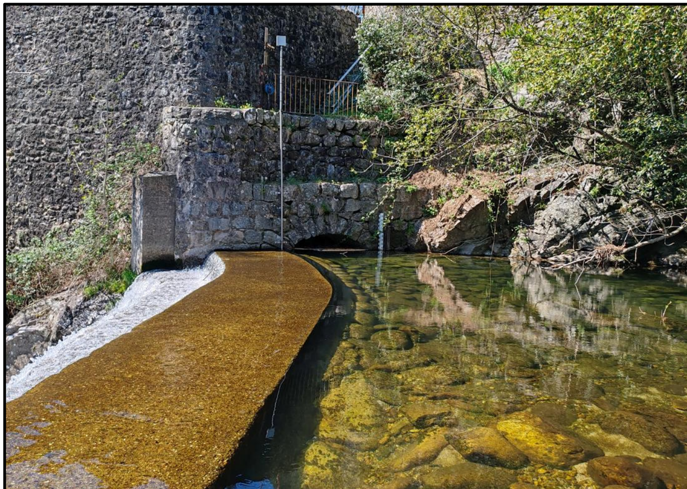
Figure 8 : Prise d'eau située en rive droite – vue amont
