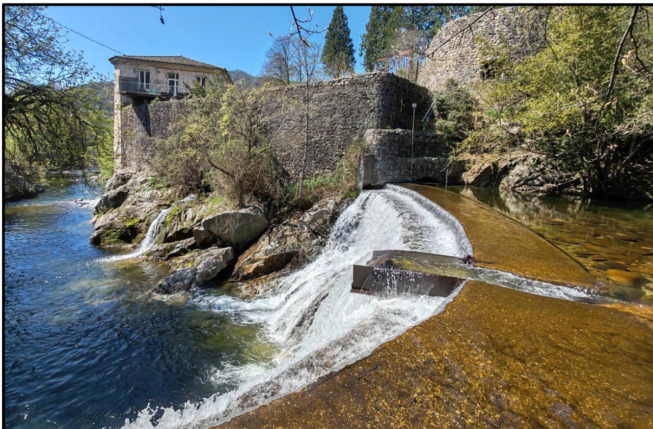
Figure 7 : Barrage de la MCHÉ – vue depuis la rive gauche
