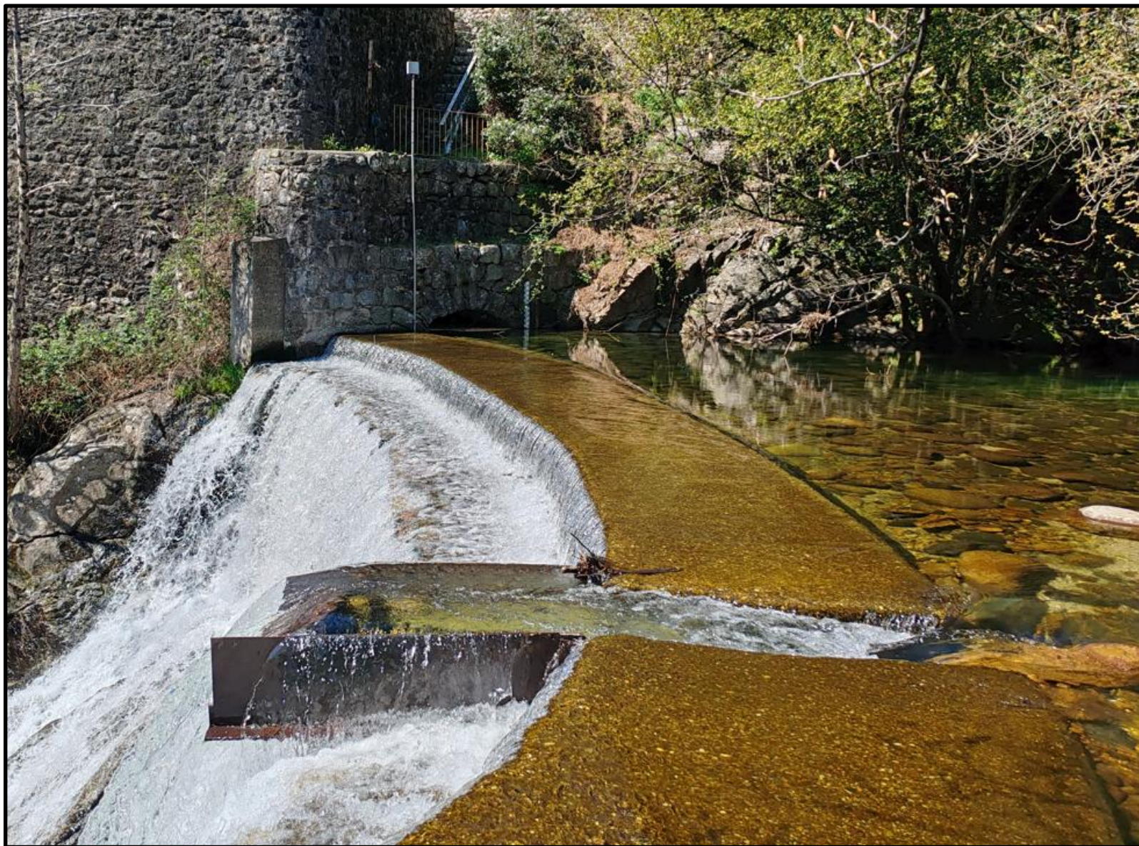
Figure 36 : Echancrure à obstruer
