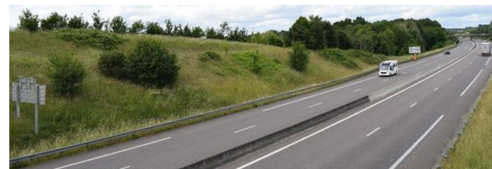
Figure 9 : illustration de l'A28 passant en déblais et dans un contexte visuel très fermé
