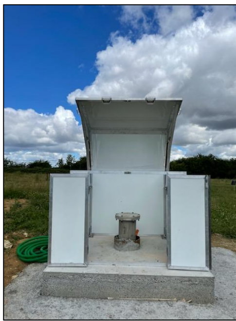
Photo 2 : Exemple d'aménagement projeté de la tête de forage
