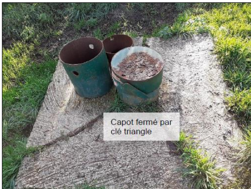
Photo 1 : Photos du forage de la Hactière par CPGF-HORIZON en janvier 2021
