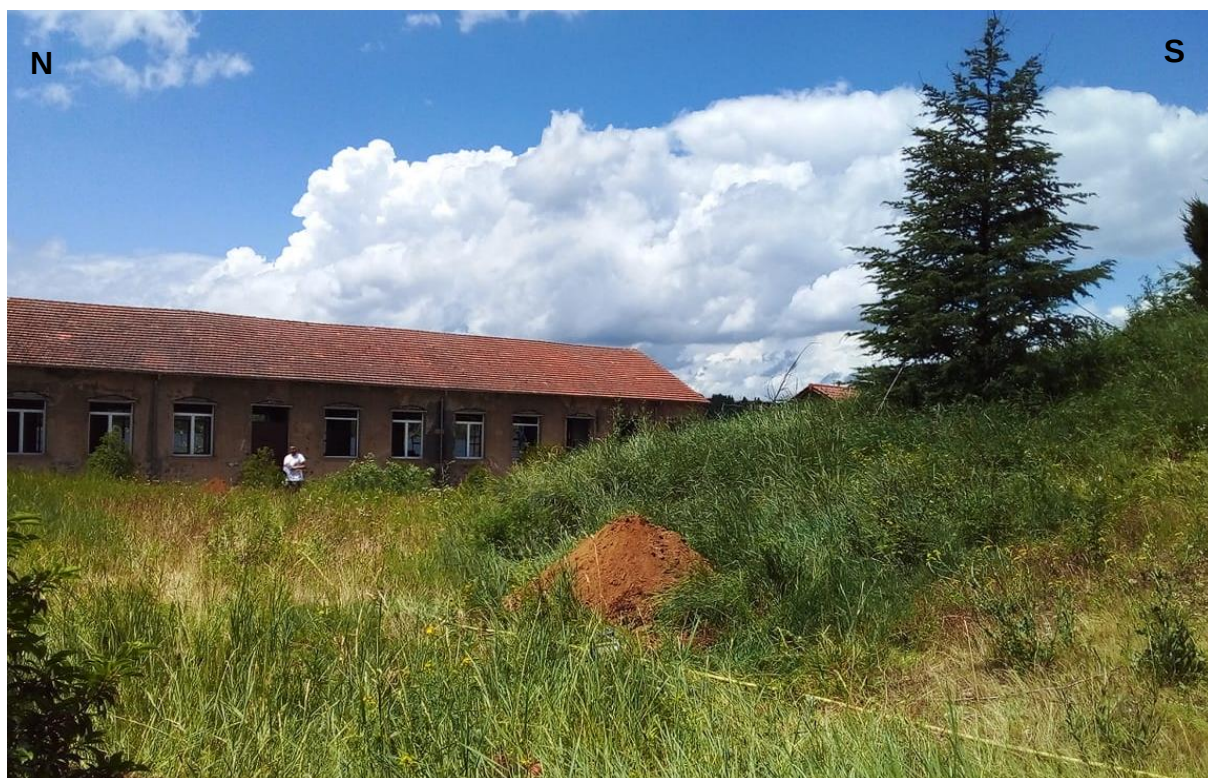
Figure 7 : Aspect général du site, aile est
