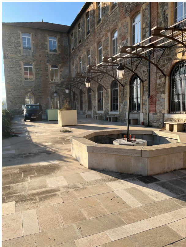
Parvis réparation des pierres au sol existantes
