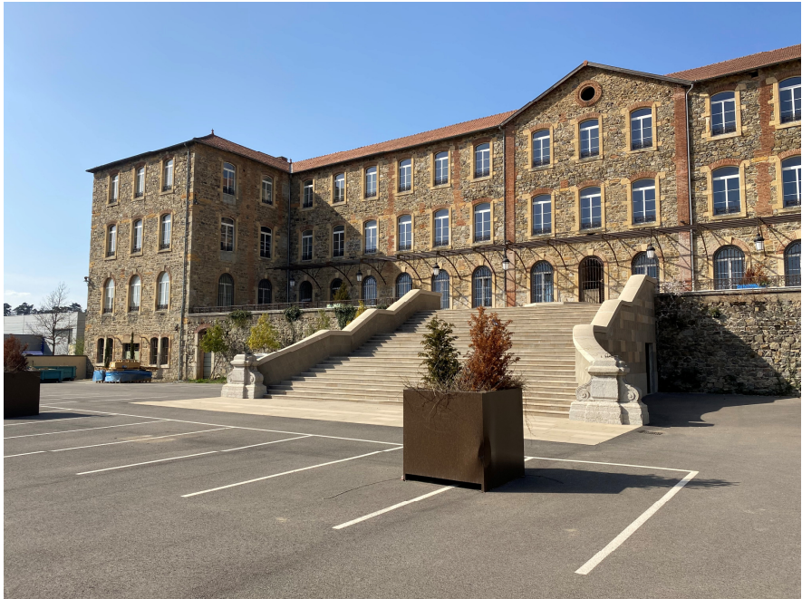
Escalier accès bâtiment
