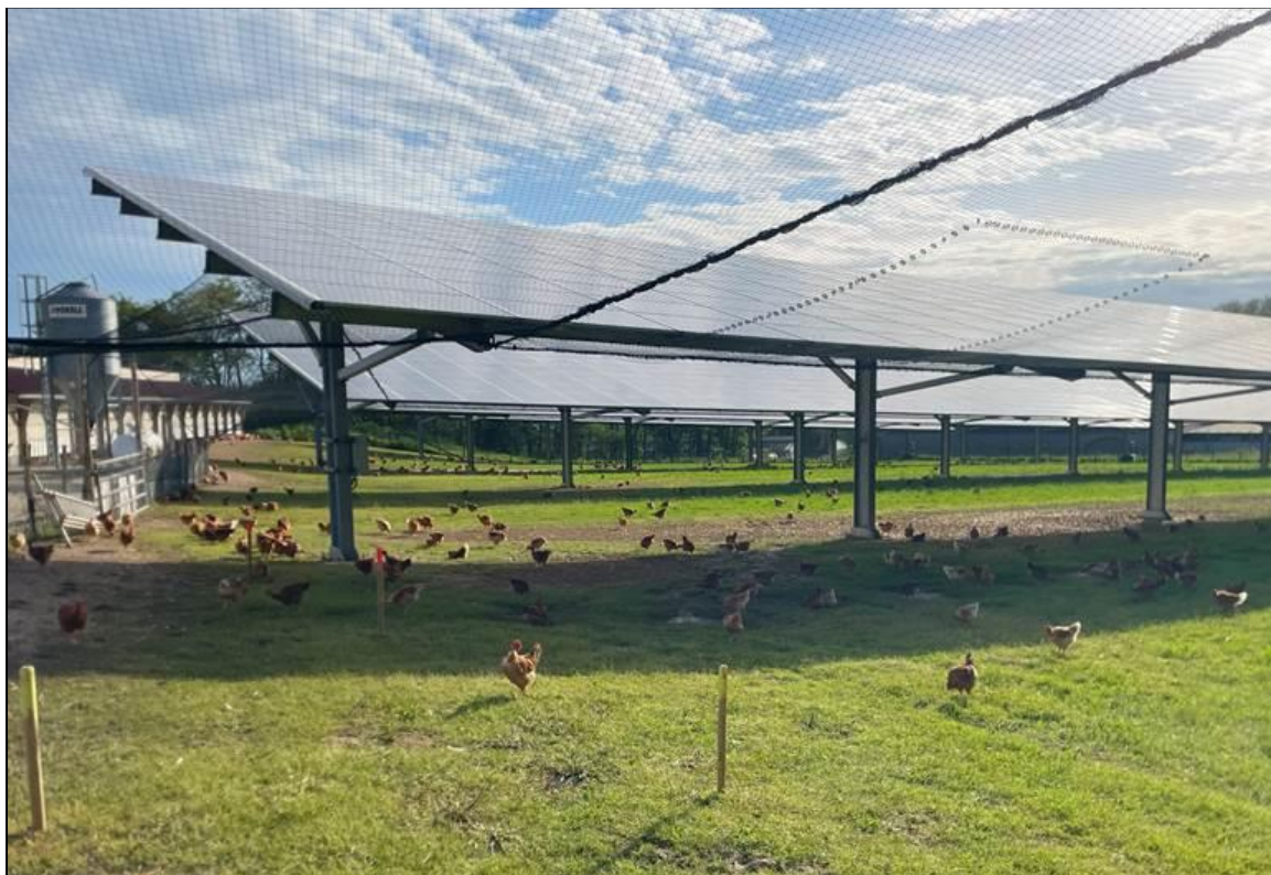
Figure 15 : Photographie d'une volière photovoltaïque Mexens (47) dans le cas d'un élevage de poulets de chair, avec à gauche le bâtiment d'élevage relié directement aux panneaux solaires et à la clôture périphérique, formant un clos total.
