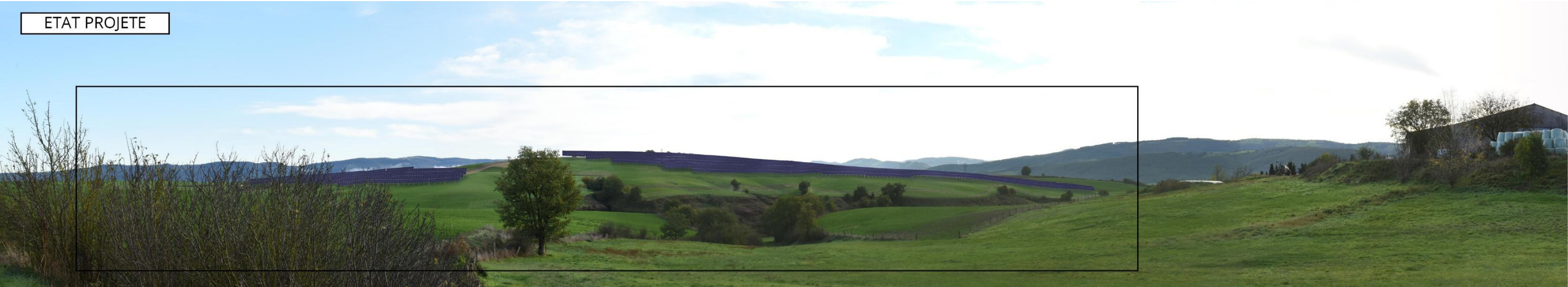
Photographie 15 : Panorama depuis le nord du hameau de Bennac (à droite sur la photographie) et zoom sur le site d'implantation du projet. Le projet apparaît en haut du plateau sur lequel il s'implante et entretient des relations visuelles avec les bâtiments du lieu de vie.
