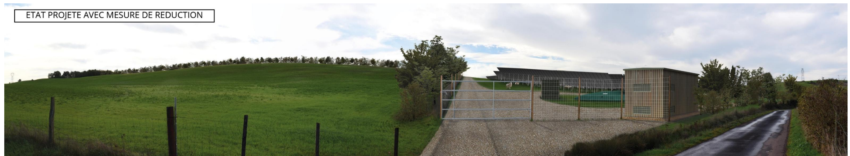
Photographie 16 : Panorama de la vue de l'entrée du site de projet, depuis la route de Bennac au nord. Les tables photovoltaïques, les équipements annexes et les pistes d'exploitation sont nettement perceptibles depuis ce point de vue en raison de la proximité. Les tables situées dans le secteur sud sont quant à elle dissimulées par le relief. La Mesure 17 de plantation de haie réduit les vues et intègre le parc et ses équipements.
