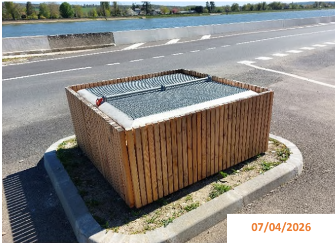
2 - Vue sur les ouvrages de ressuyage des crues
