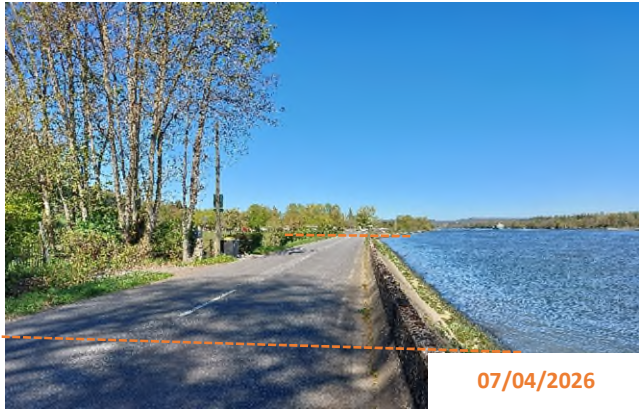
9 - Vue depuis l'amont de la Seine en direction de la zone de projet.
