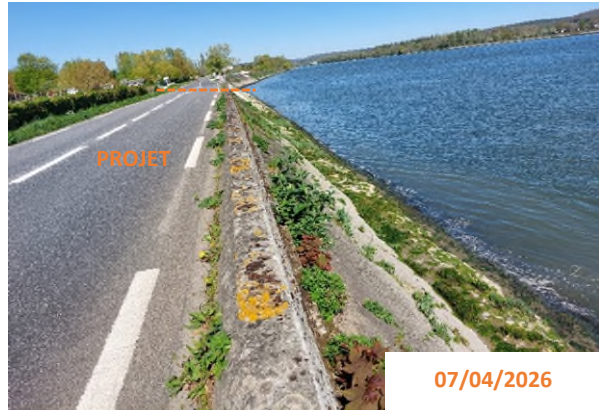
10 - Etat actuel de la digue
