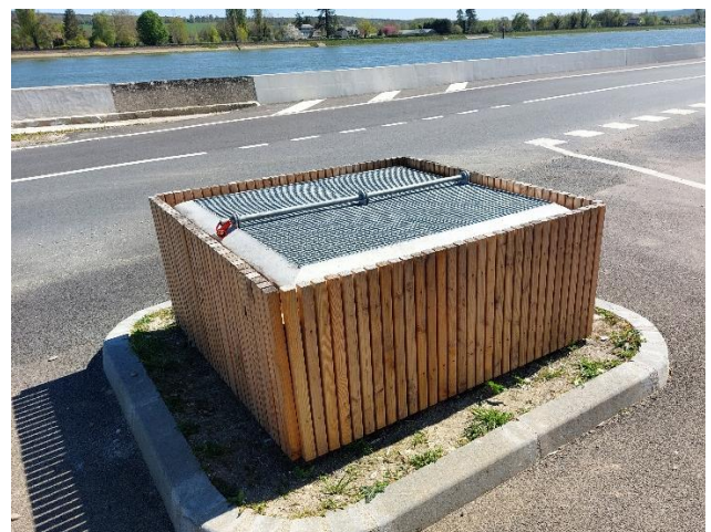
Figure 12 Vue n°2 sur les ouvrages de ressuyage des crues réalisée en 2024
