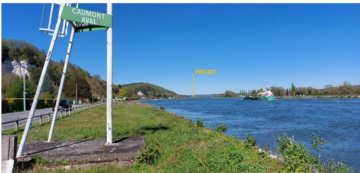
Figure 25 Vue 14 depuis le point de repère Caumont aval.
