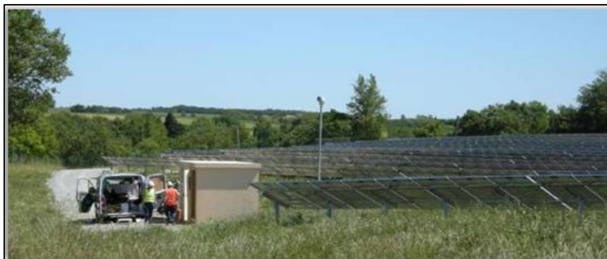
Figure 53 : Opération de maintenance
