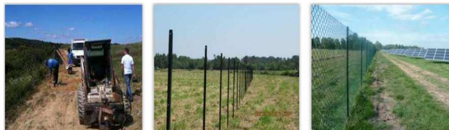
Figure 43 : Mise en place de la clôture (pose des ancrages, des piquets et du maillage)
