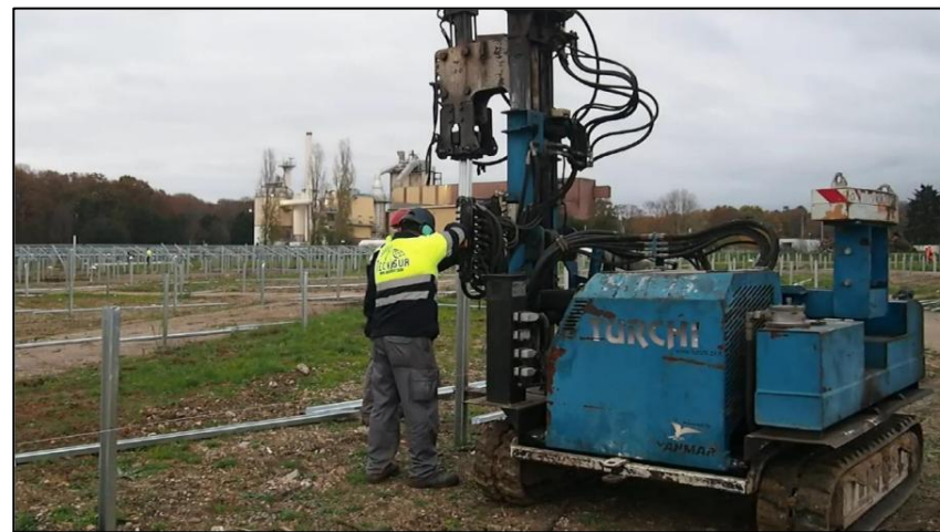
Figure 40 : Battage des pieux
