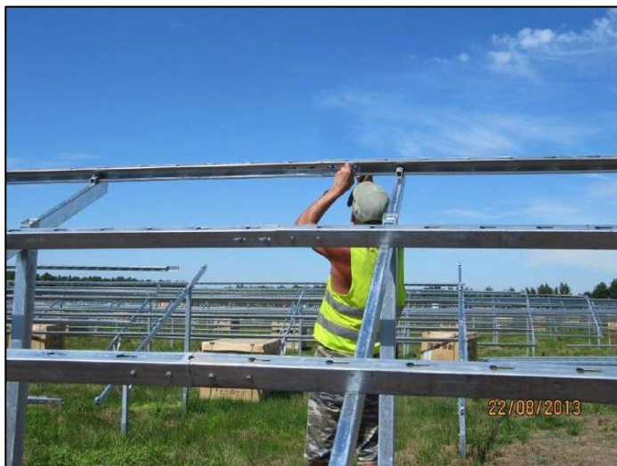
Figure 36 : Systèmes de fixation pour installation photovoltaïque
