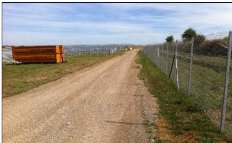
Figure 42 : Exemple d'une bande de roulement adaptée aux véhicules lourds
