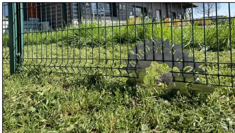
Figure 44 : Clôture favorable au passage de la petite faune
