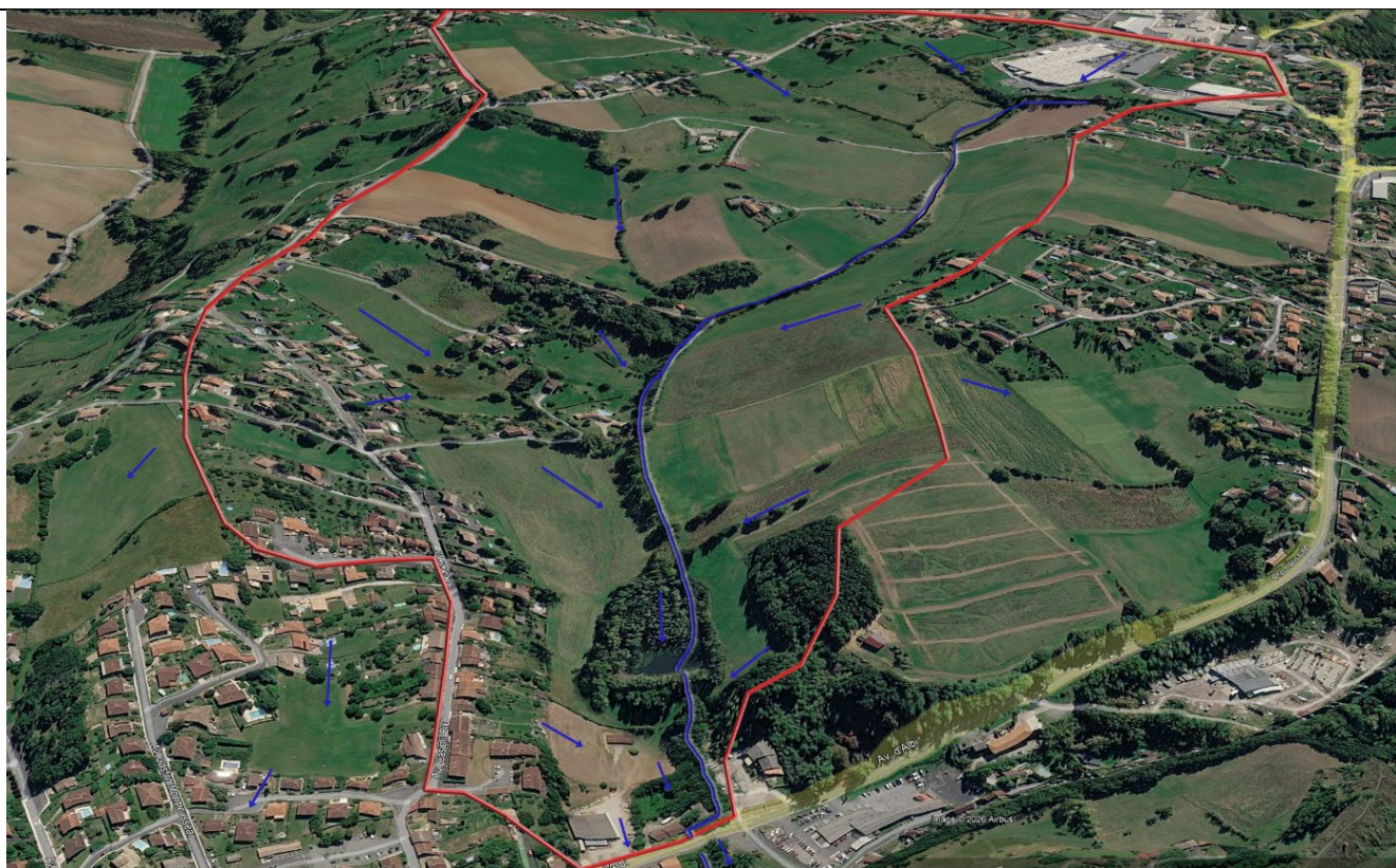
Figure 8 : Fonctionnement du bassin versant du site
