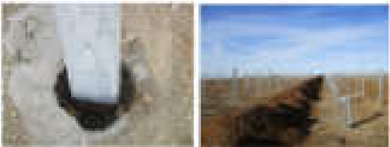
Figure 113 : Exemple de fondation type pieux (source : QENERGY, 2025)
