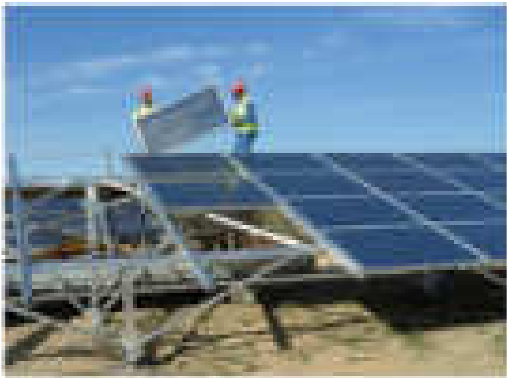
Figure 122 : Exemple de mise en place des panneaux sur les structures (source : QENERGY, 2025)
