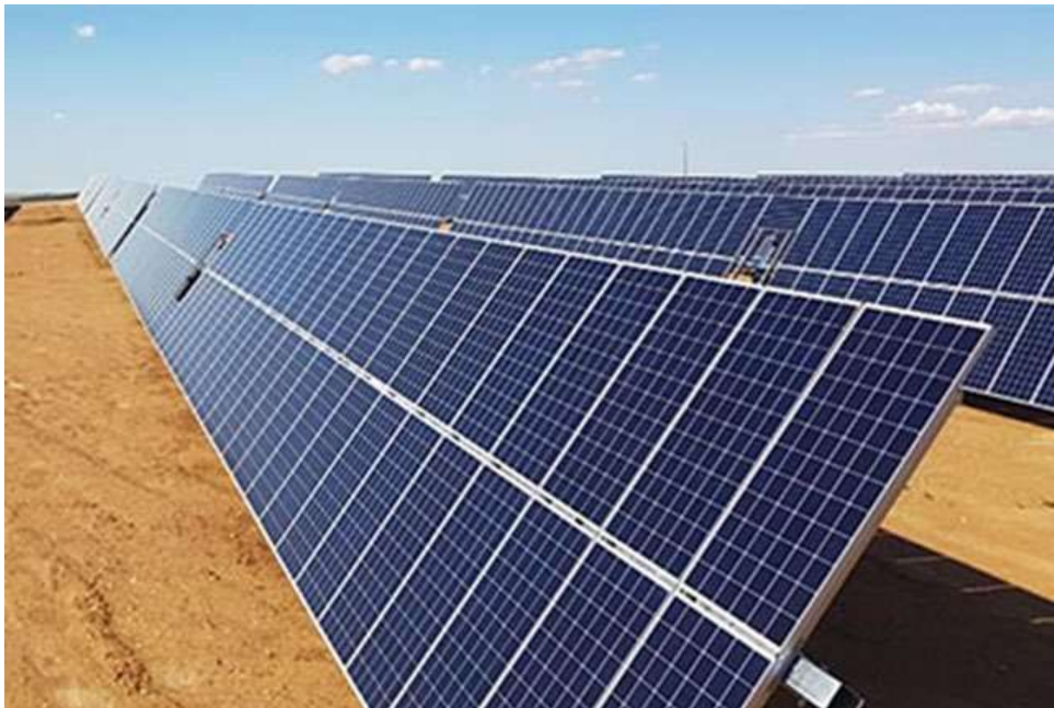
Figure 4 : Exemple de tracker - source Gonvarri Solar Steel
