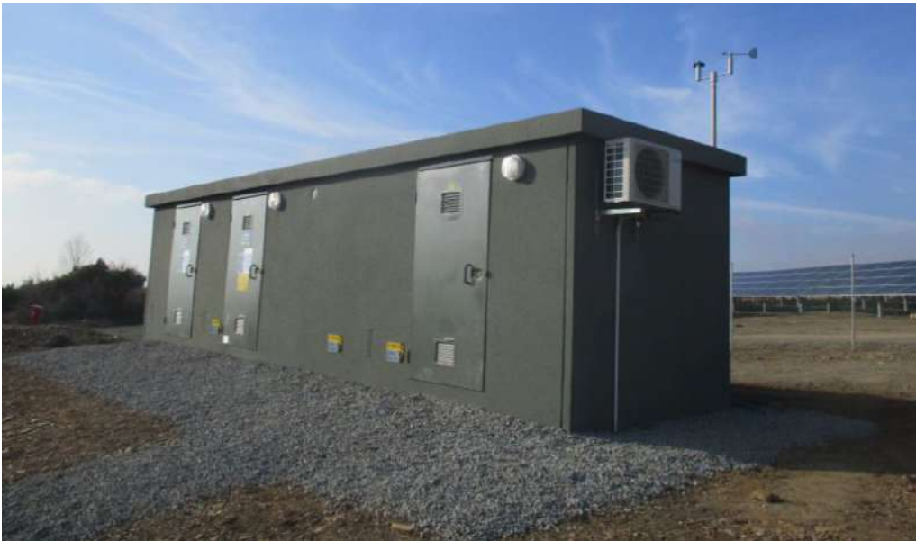
Figure 6 : Exemple de structure de livraison (source : QENERGY, 2025)
