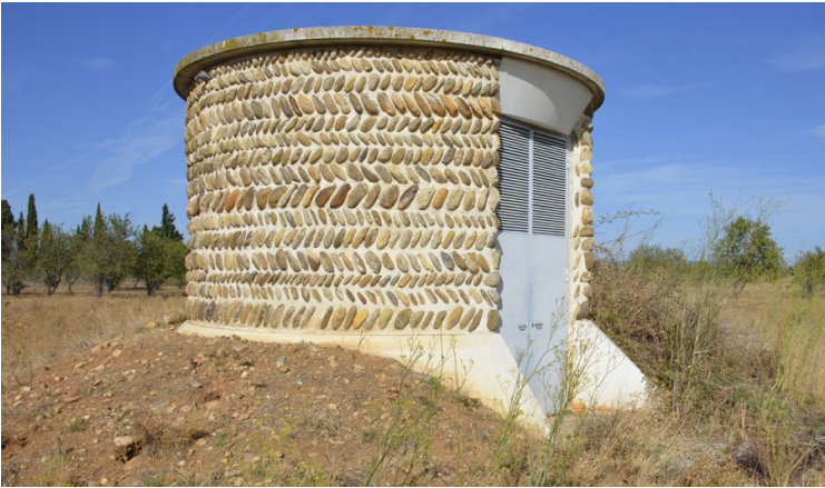
Exemple de traitement des équipements techniques sur l’aire d’autoroute valorisant les galets de la Crau.
