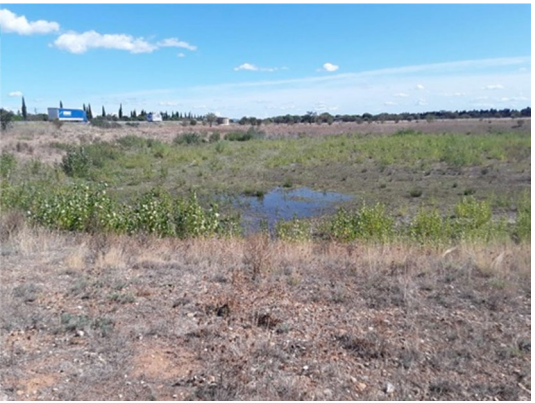
Bassin de rétention après des pluies
