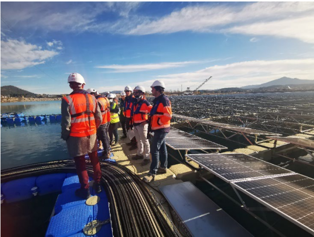
Visite du parc photovoltaïque flottant de Peyrolles (13)
