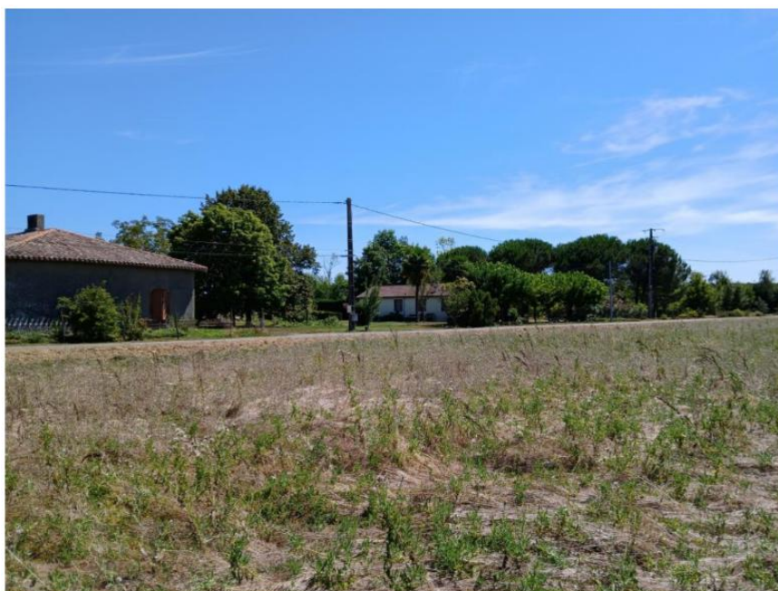
Figure 16: Photo prise depuis le Sud du site vers l'extérieur témoignant de la proximité immédiate de plusieurs habitations avec le projet. ( Source : ETEN Environnement)
