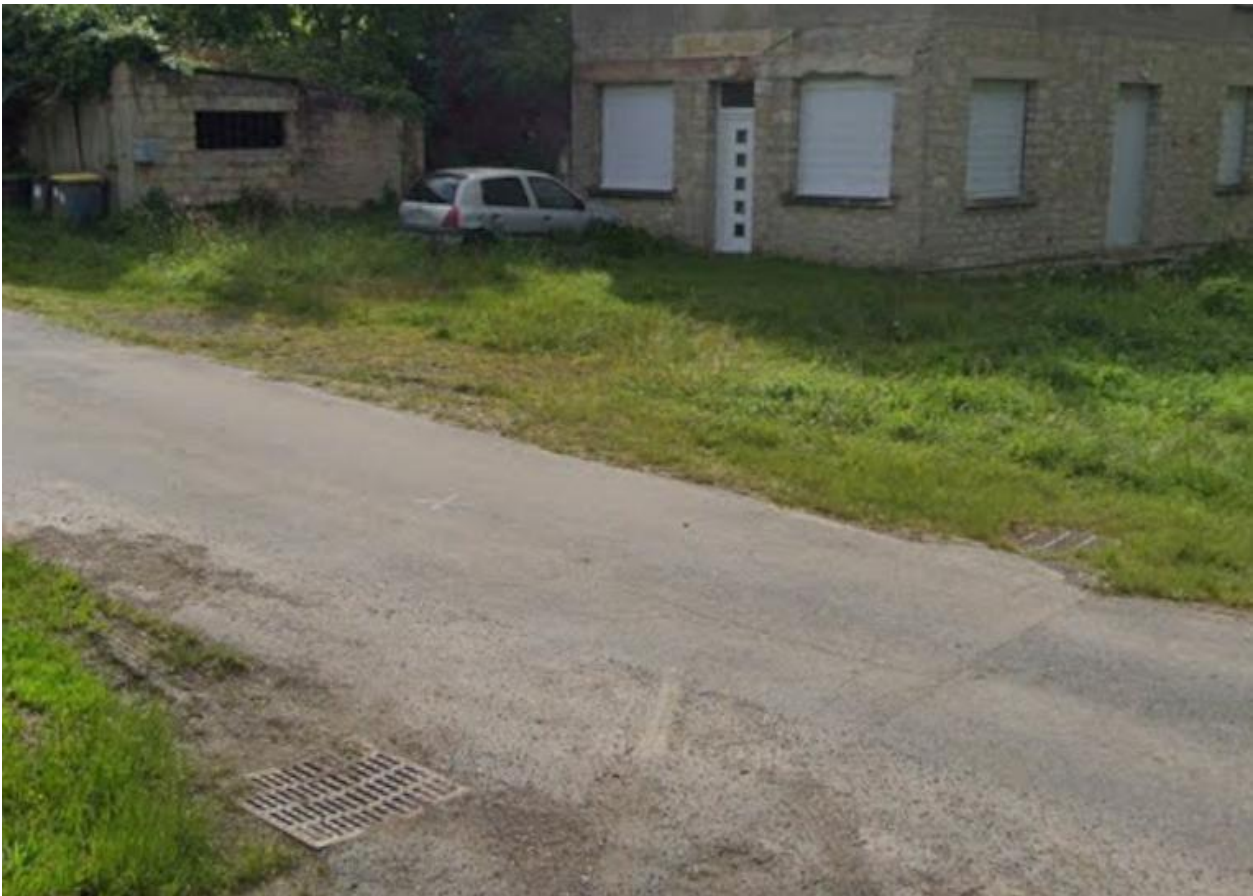
Figure 17: Grilles EP rue du Soupir avant exutoire dans le canal (Google maps)
