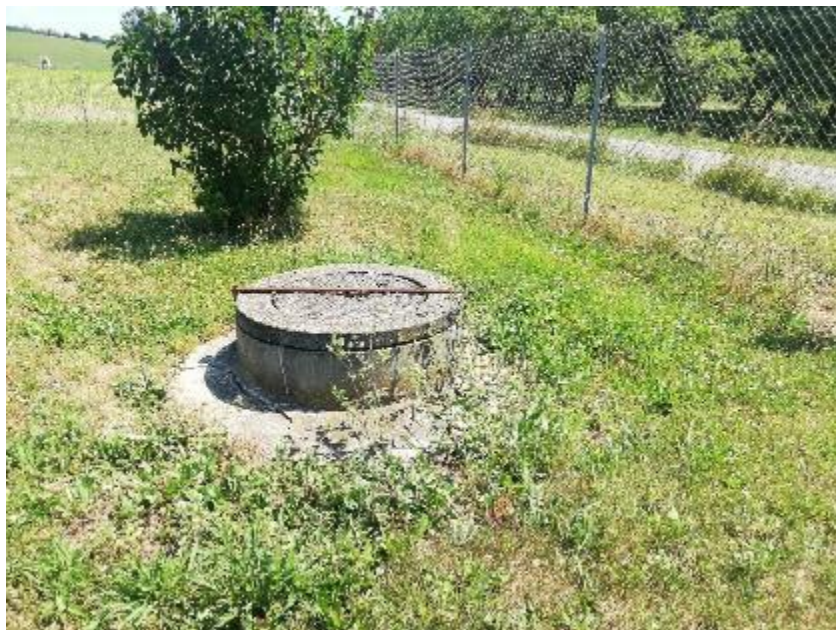
Figure 59 : Vue du forage
