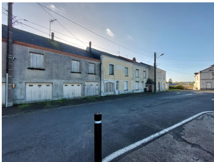
Figure 2 : Bâtiments présents sur la zone d'étude
