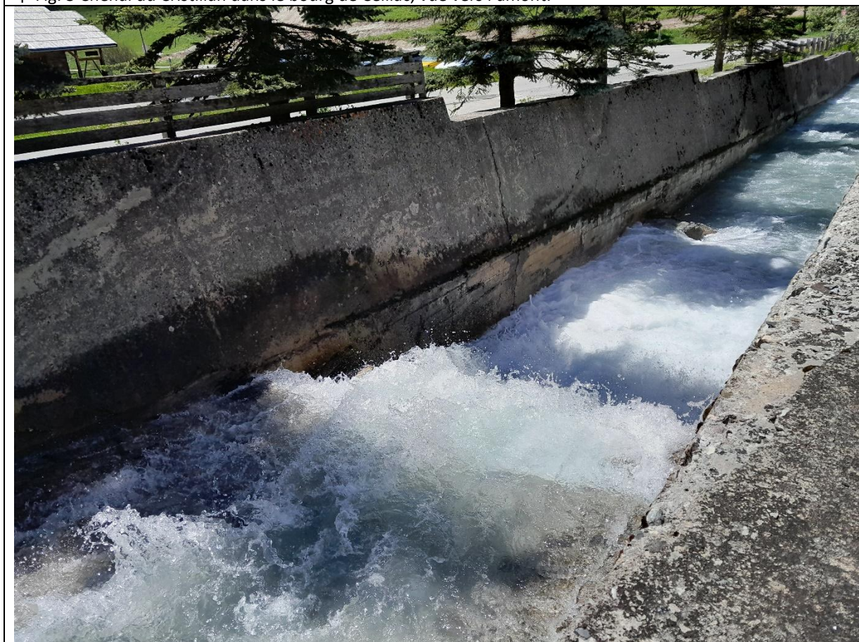
↑ Fig. 4 Vue vers l'aval, seuils existants
