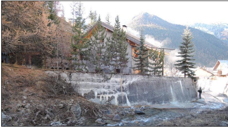
Figure 22 : Exemple de présence de végétation arborée plantée côté val à proximité immédiate du chenal (Source ONF-RTM, VTA 2015)
