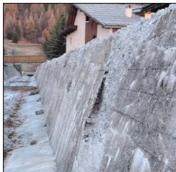
Figure 19 : Illustration du phénomène de décollement de la peau du béton : Tronçon 3 – RD. (Source ONF-RTM, VTA 2015)
