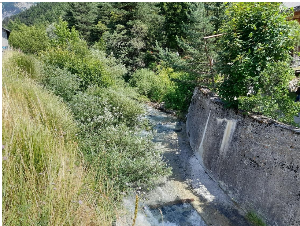
↑ Fig. 1 Entrée du chenal du Cristillan dans le bourg de Ceillac. Vue vers l'amont – nord.
