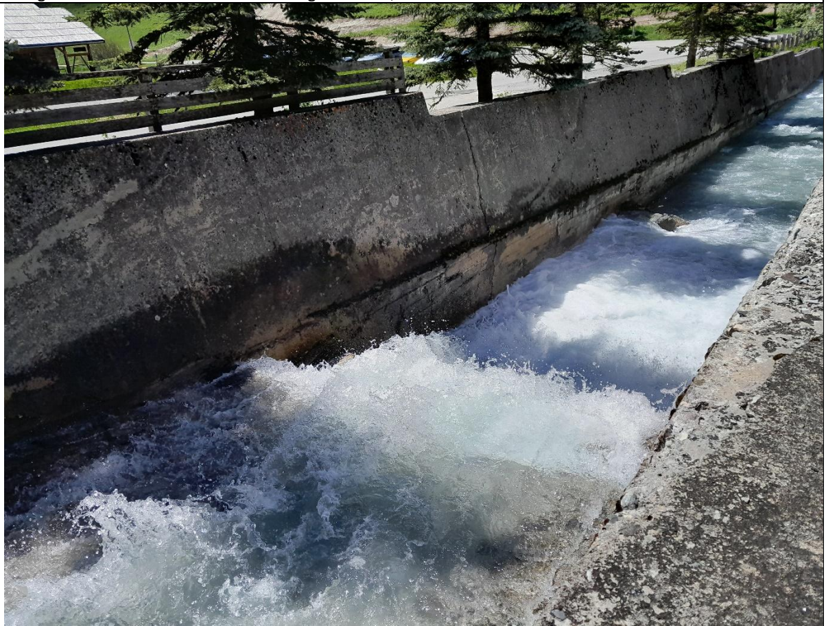
↑ Fig. 4 Vue vers l'aval, seuils existants
