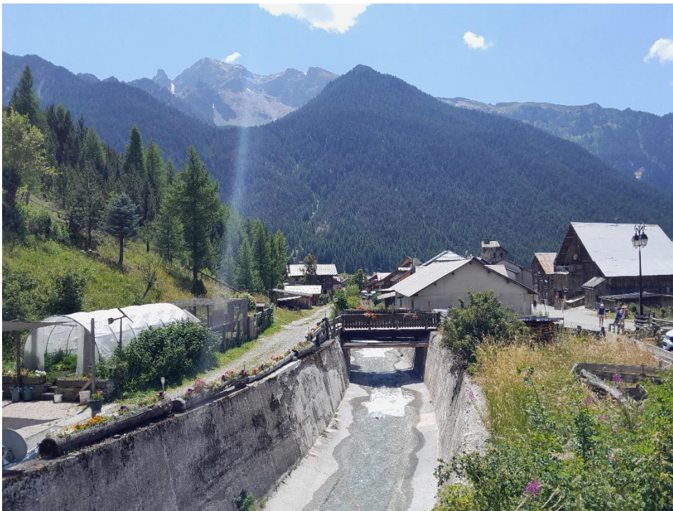
↑ Fig. 2 Entrée du chenal du Cristillan dans le bourg de Ceillac, avec le premier pont. Vue vers l'aval – sud.
