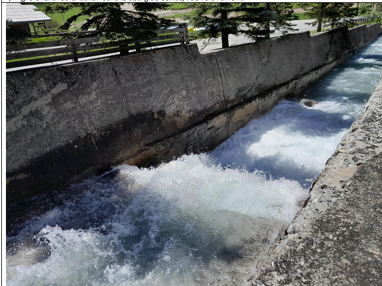
↑ Fig. 4 Vue vers l'aval, seuils existants
