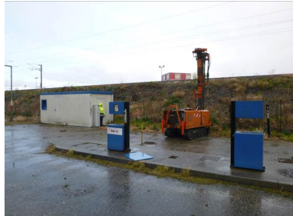
Figure 14 : Vue de la réalisation du sondage ST7
