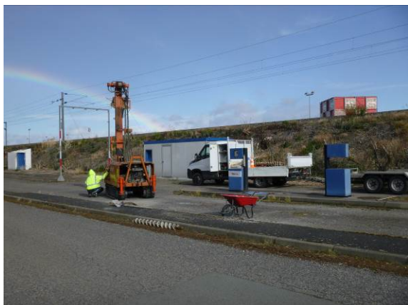
Figure 7 : Vue de la réalisation du sondage ST4
