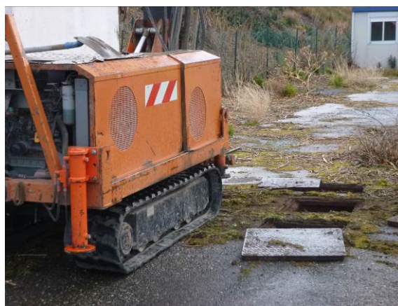
Figure 24 : Vue de la réalisation du sondage ST9
