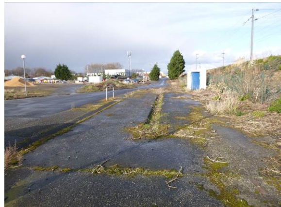
Figure 16 : Vue de l'aire de lavage
