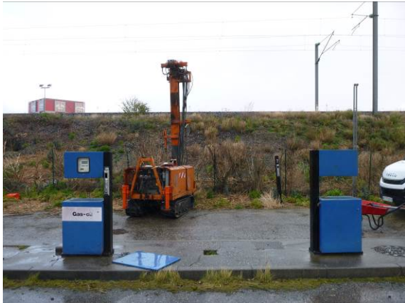
Figure 13 : Vue de la réalisation du sondage ST7
