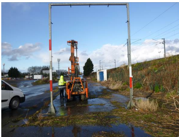
Figure 17 : Vue de la réalisation du sondage ST8
