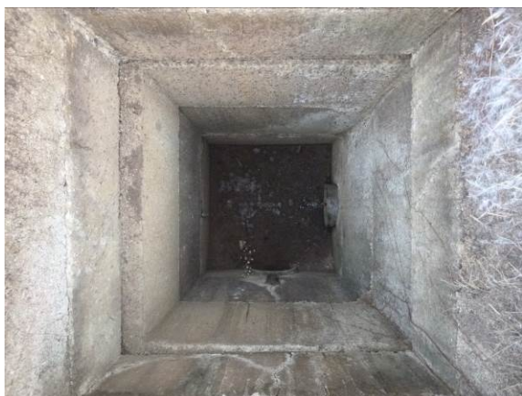
Figure 21 : Vue du regard de rejet des eaux en sortie du séparateur d'hydrocarbures
