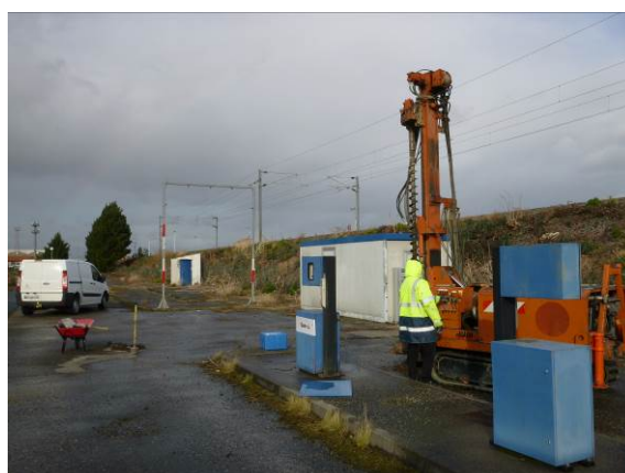
Figure 12 : Vue de la réalisation du sondage ST6
