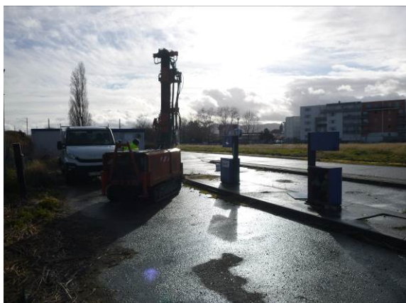
Figure 9 : Vue de la réalisation du sondage ST5
