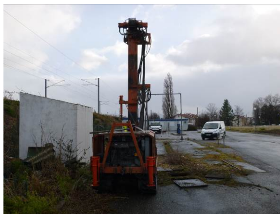
Figure 22 : Vue de la réalisation du sondage ST9
