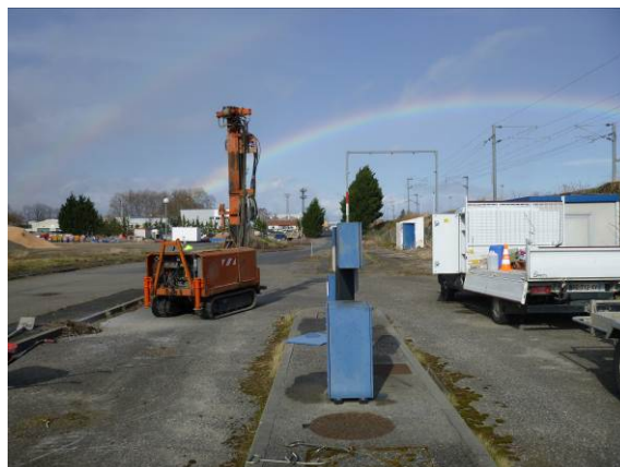
Figure 8 : Vue de la réalisation du sondage ST4
