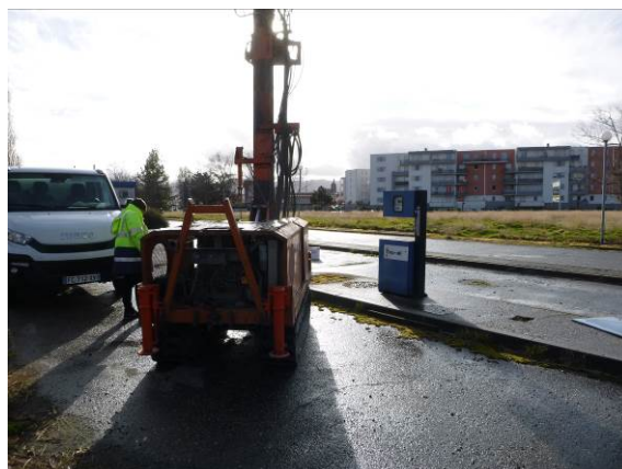
Figure 10 : Vue de la réalisation du sondage ST5
