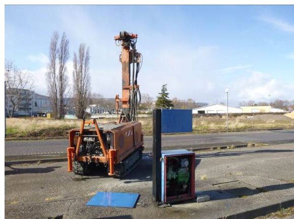
Figure 6 : Vue de la réalisation du sondage ST3
