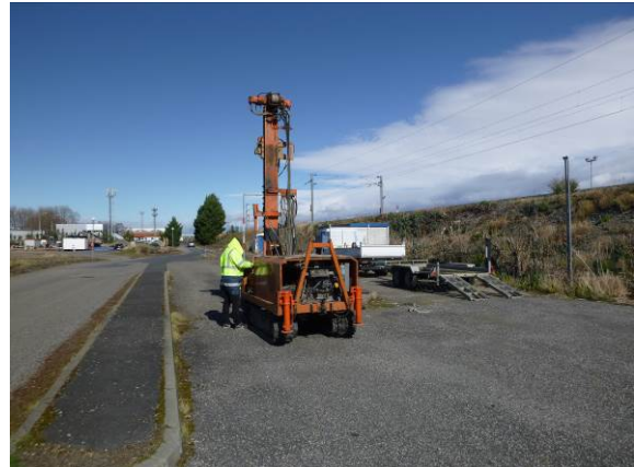
Figure 2 : Vue de la réalisation du sondage ST1
