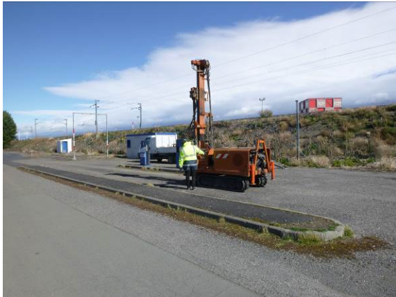
Figure 1 : Vue de la réalisation du sondage ST1
