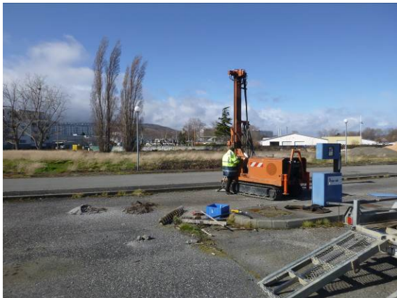
Figure 3 : Vue de la réalisation du sondage ST2
