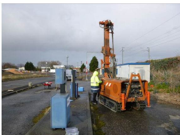
Figure 11 : Vue de la réalisation du sondage ST6
