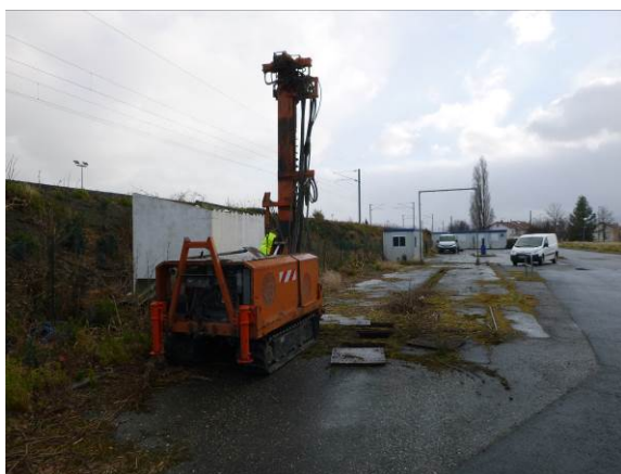
Figure 23 : Vue de la réalisation du sondage ST9
