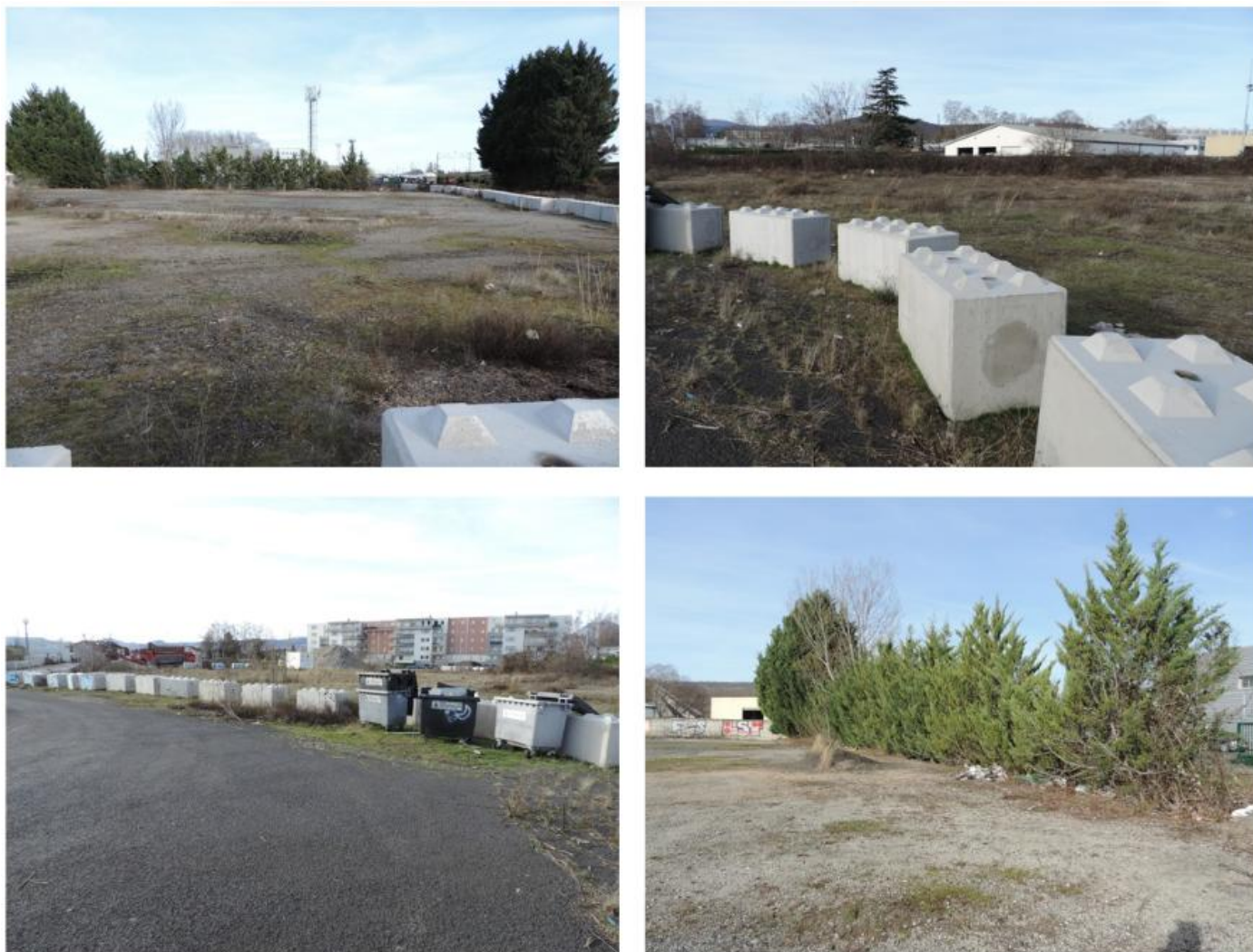
Figure 17 : Photographies de la zone d'étude : la friche industrielle, l'alignement d'arbres et la route.
