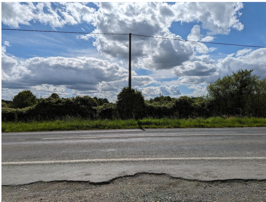
Vue n°2 depuis la route de Segré (02/05/2024)
