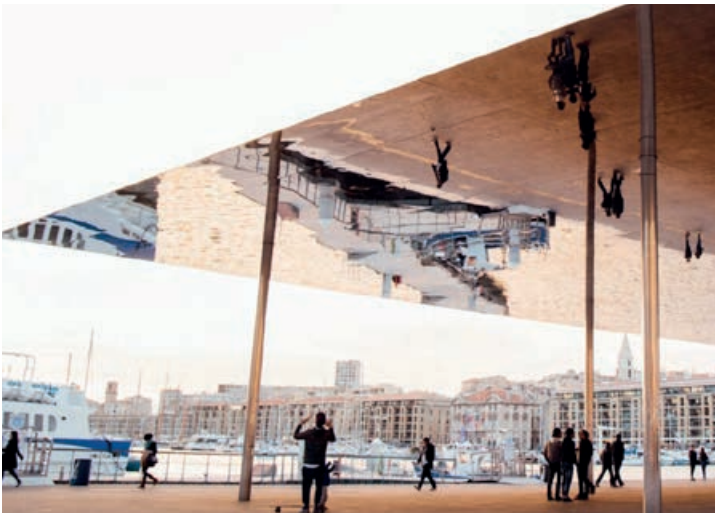
Tôles d'habillage planes: Inox 316L : Qualité Marine et Low Carbon
