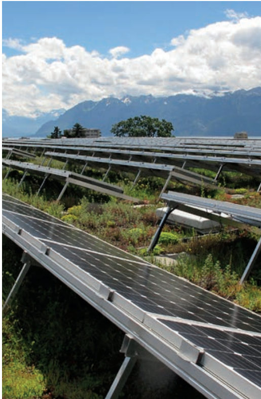
Principe de toiture biosolaire
