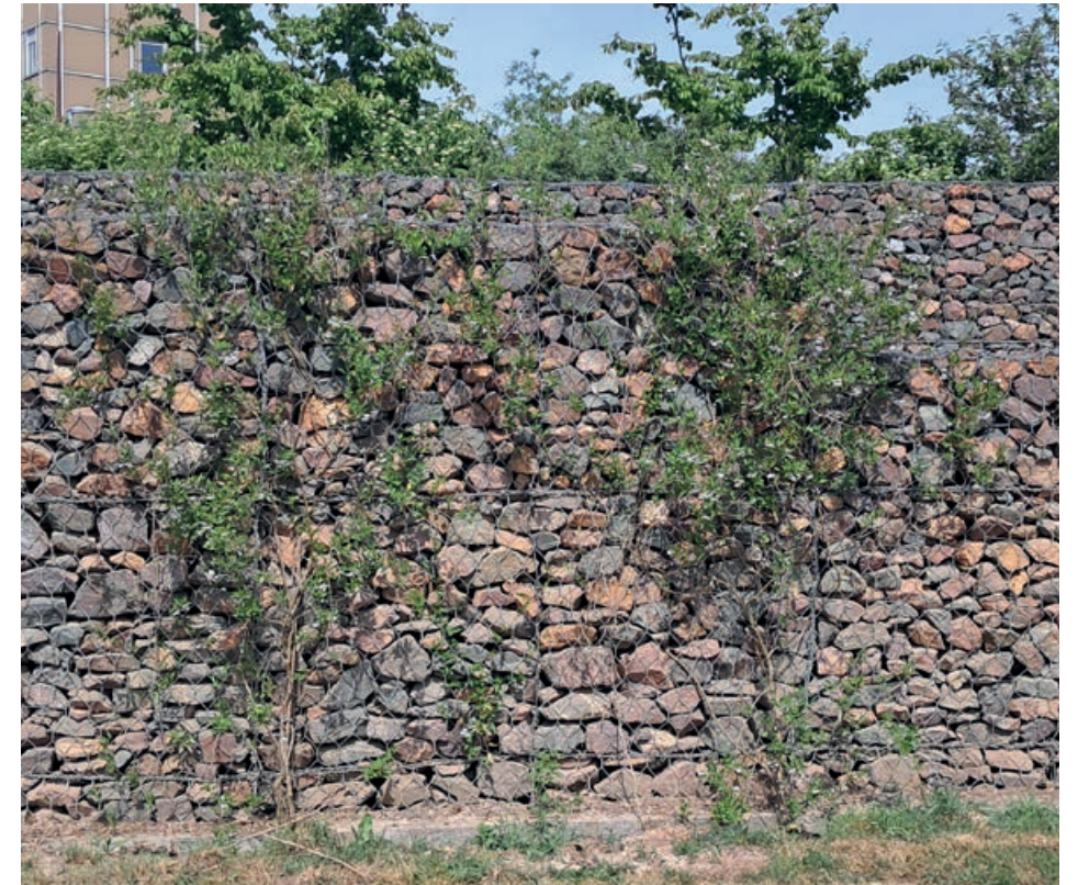
Gabions de pierres naturelles végétalisés
