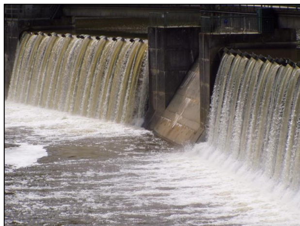
Figure 27 : La Mayenne en surverse de Saint Fraimbault, après les fortes pluies d'avril 2012 - DMEAU
